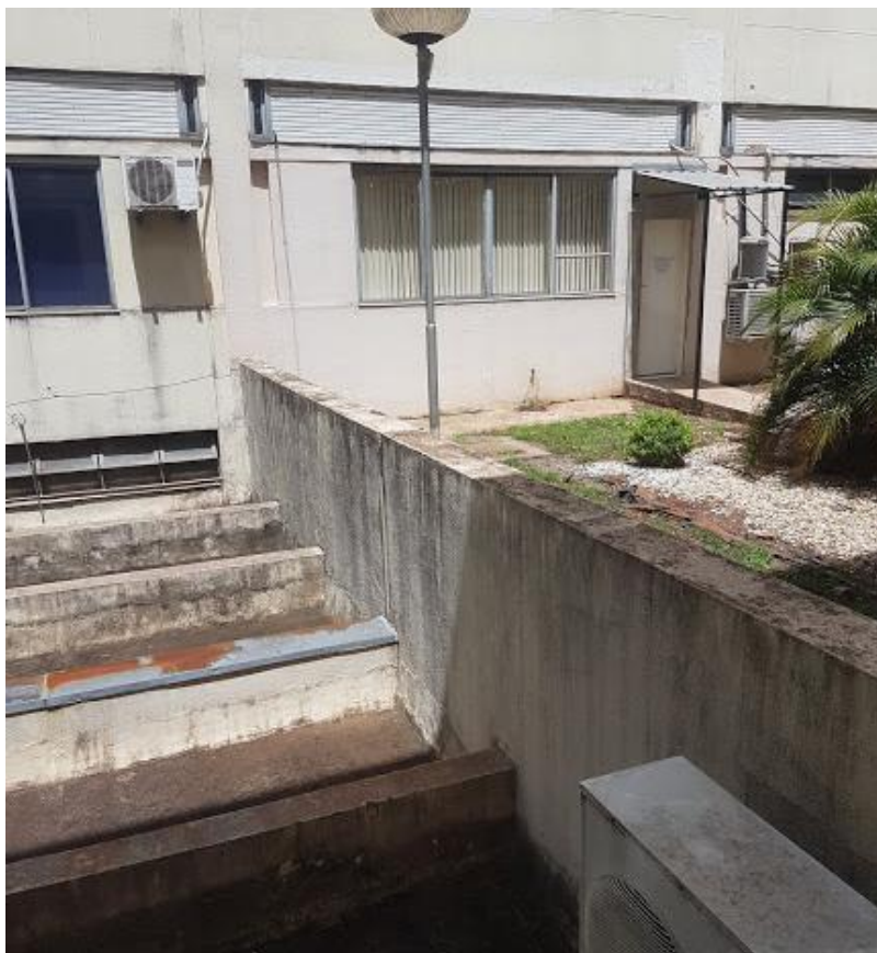
Figura 14 - Laje do subsolo no Pátio 1
