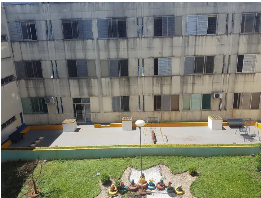
Figura 18 - Pátio 4 - vista do pavimento superior
