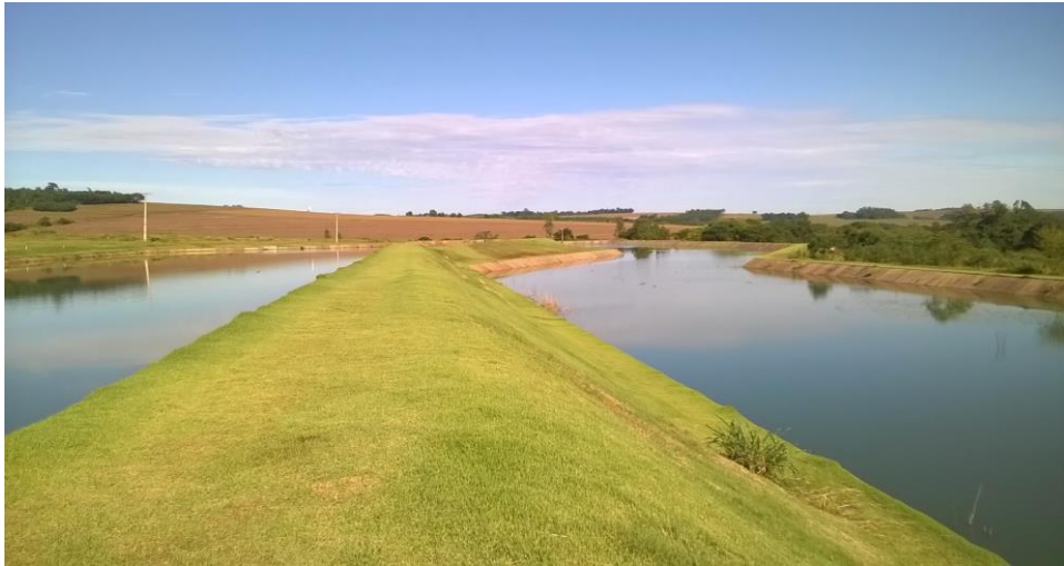
Figura 4 – Estação de Tratamento de Esgoto – ETE Guavirá.
