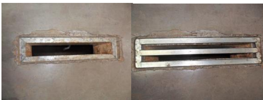
Figura 85. Grelhas de sucção.
