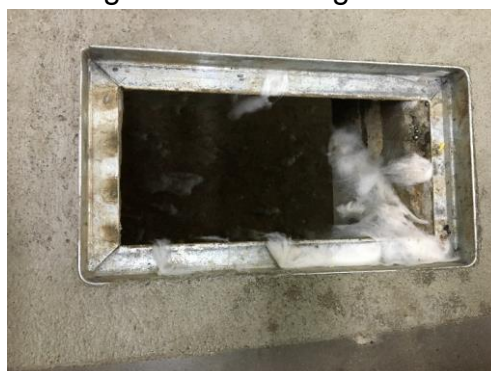
Figura 68. Grelha exposta com aglomerado de algodão.
