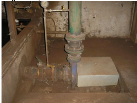
Figura 26. Bomba de água da piscina.
