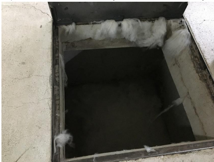
Figura 69. Tampa de entrada de verificação dos túneis de sucção.
