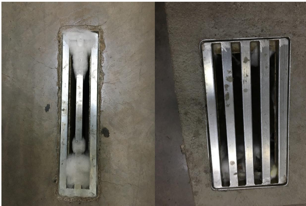
Figura 67. Grelhas com acúmulo de particulado de algodão.
