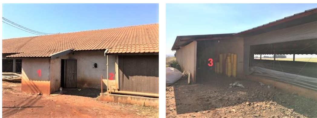
Figura 14: Sala de controle (1) e porta de acesso ao pad cooling do aviário AV1 (2). Ambiente do sistema de aquecimento do aviário AV2 (3).
