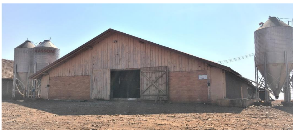
Figura 12: Fachada frontal do aviário AV1
