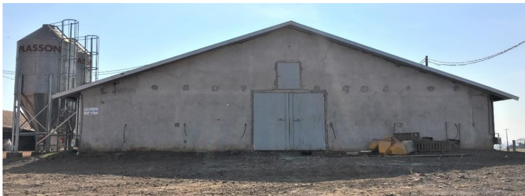
Figura 13: Fachada frontal do aviário AV2.
