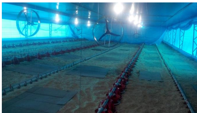
Figura 3: Aviário blue house . Fonte: INTEEL AUTOMAÇÕES, 2015.
