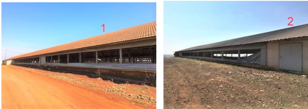
Figura 18: Telha cerâmica de barro do aviário AV1 (1). Telha de aluzinco trapezoidal TRP35 do aviário AV2 (2).
