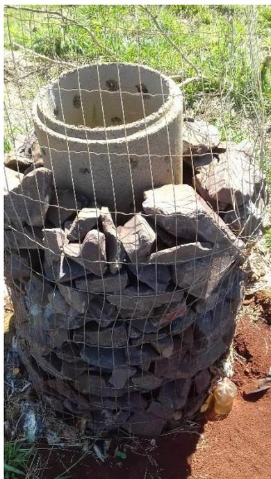
**FIGURA 5.** Duto vertical para escoamento do biogás.
