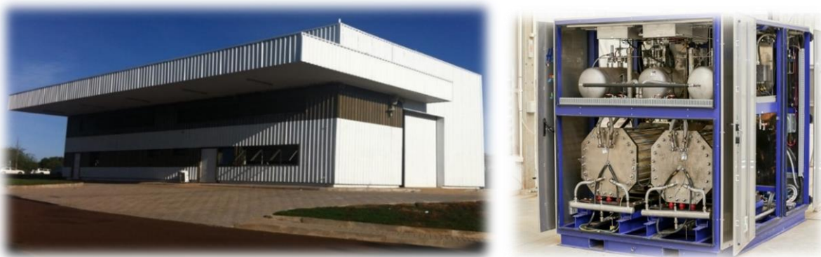
Figura 2.2: Vista panorâmica e interna da PPH instalada no PTI.
