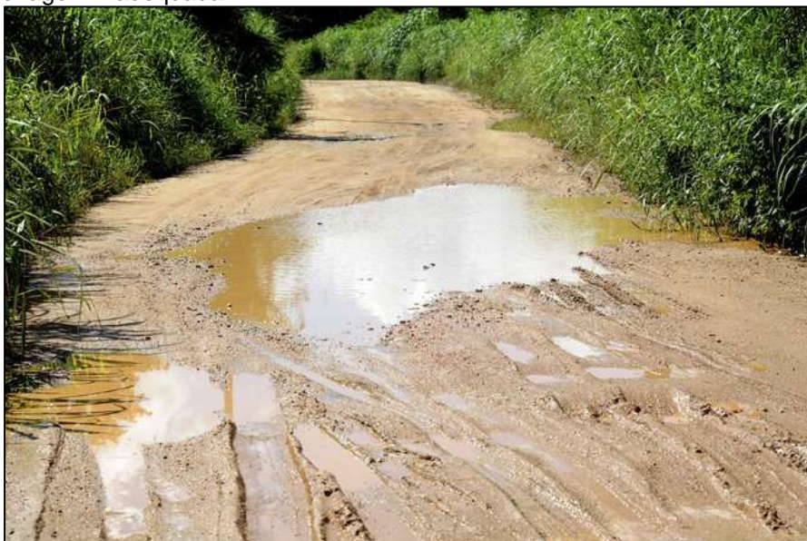
Figura 3 - Drenagem Inadequada
