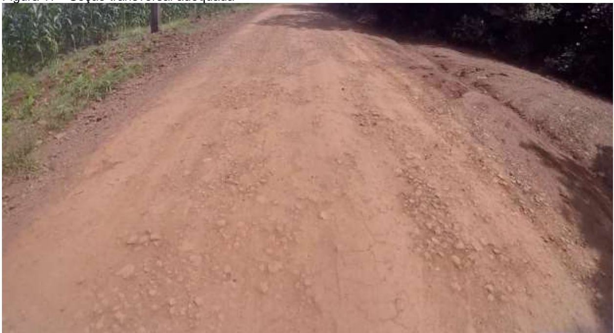
Figura 17 - Seção transversal adequada
