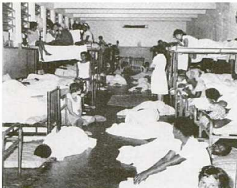
SAM - Dormitório - Pavilhão Anchieta - Quintino, RJ, 1964 (data provável)
