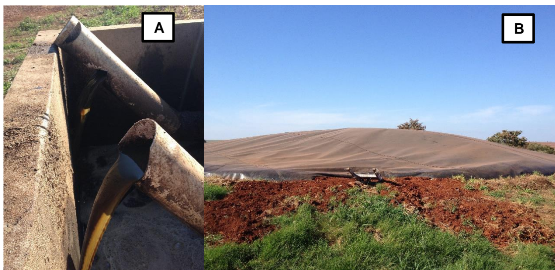
Figura 6 A: Duto de saída do biofertilizante; B: Digestor lagoa coberta.
