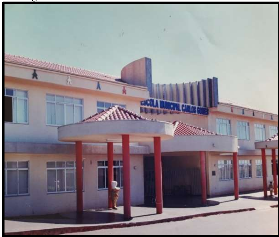
Figura 96. Fachada da estrutura nova da E.M. Carlos Gomes
