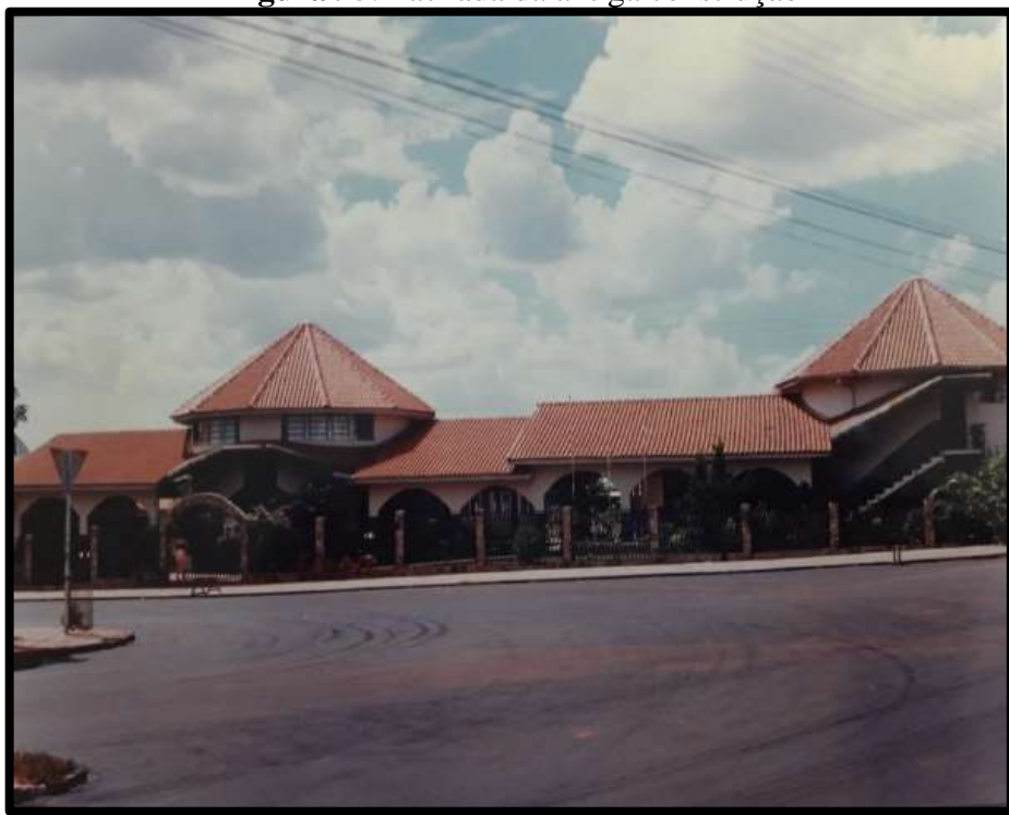
Figura 95. Fachada da antiga construção
