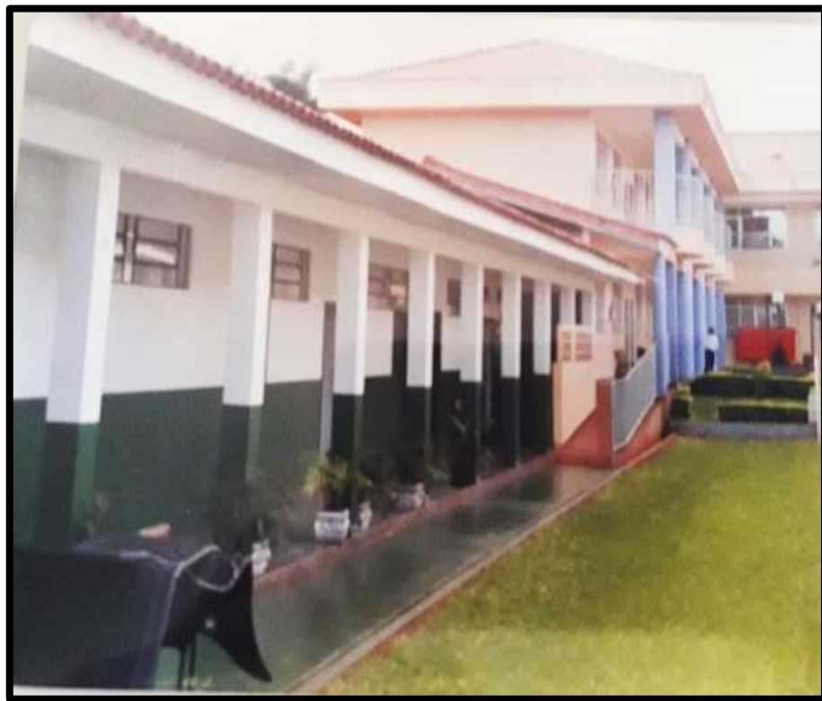
Figura 93. O prédio pintado em branco e verde é a antiga instalação da Escola Municipal Carlos Gomes
