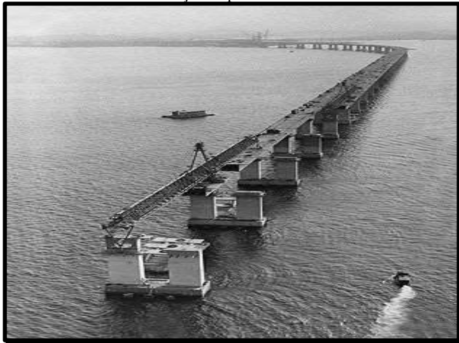
Figura 1. Vista aérea da construção da ponte Rio-Niterói em 30 de abril de 1973
