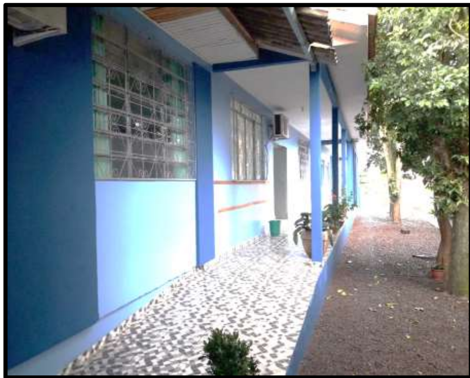
Figura 57. Construções de quatro salas de aula com capacidade para o atendimento de 100 alunos
