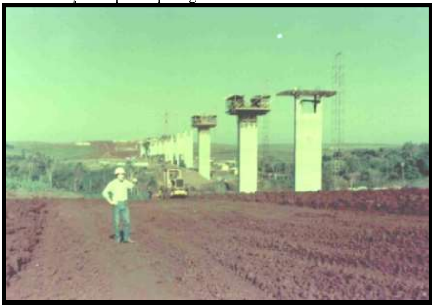
Figura 43. Construção da ponte que ligaria Santa Helena a Marechal Cândido Rondon
