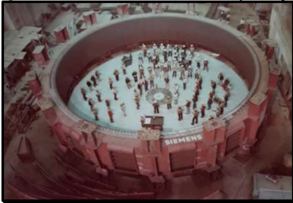
Figura 15. Vista do estator da Unidade 15 (SIEMENS) em pré-montagem
