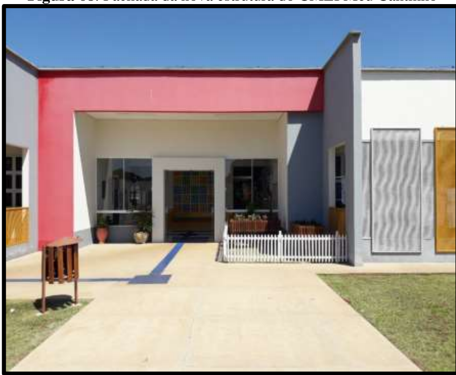
Figura 68. Fachada da nova estrutura do CMEI Meu Cantinho
