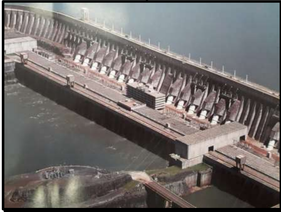
Figura 13. Imagem aérea da barragem principal e as 20 tomadas de força ao longo da barragem
