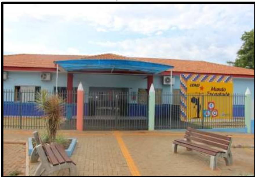
Figura 99. CMEI Mundo Encantado, construído no Distrito de São José do Itavó
