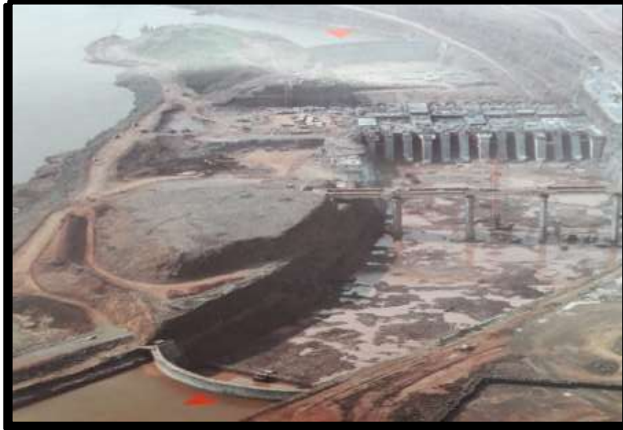
Figura 8. Vista área do canal de desvio do rio para as construções da barragem principal e da casa de força
