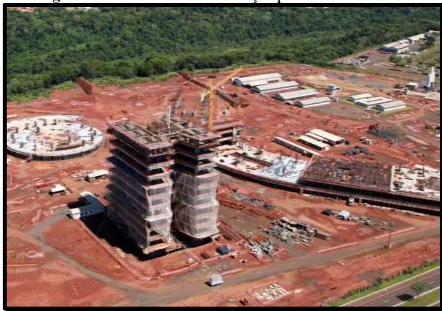
Figura 23. Vista aérea da construção paralisada da UNILA
