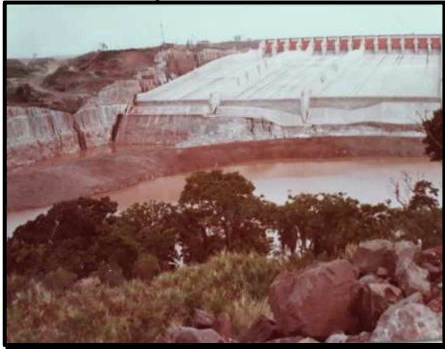
Figura 14. Vertedouro com as 14 comportas fechadas antes do primeiro teste com água. Imagem tirada em 07/10/1982
