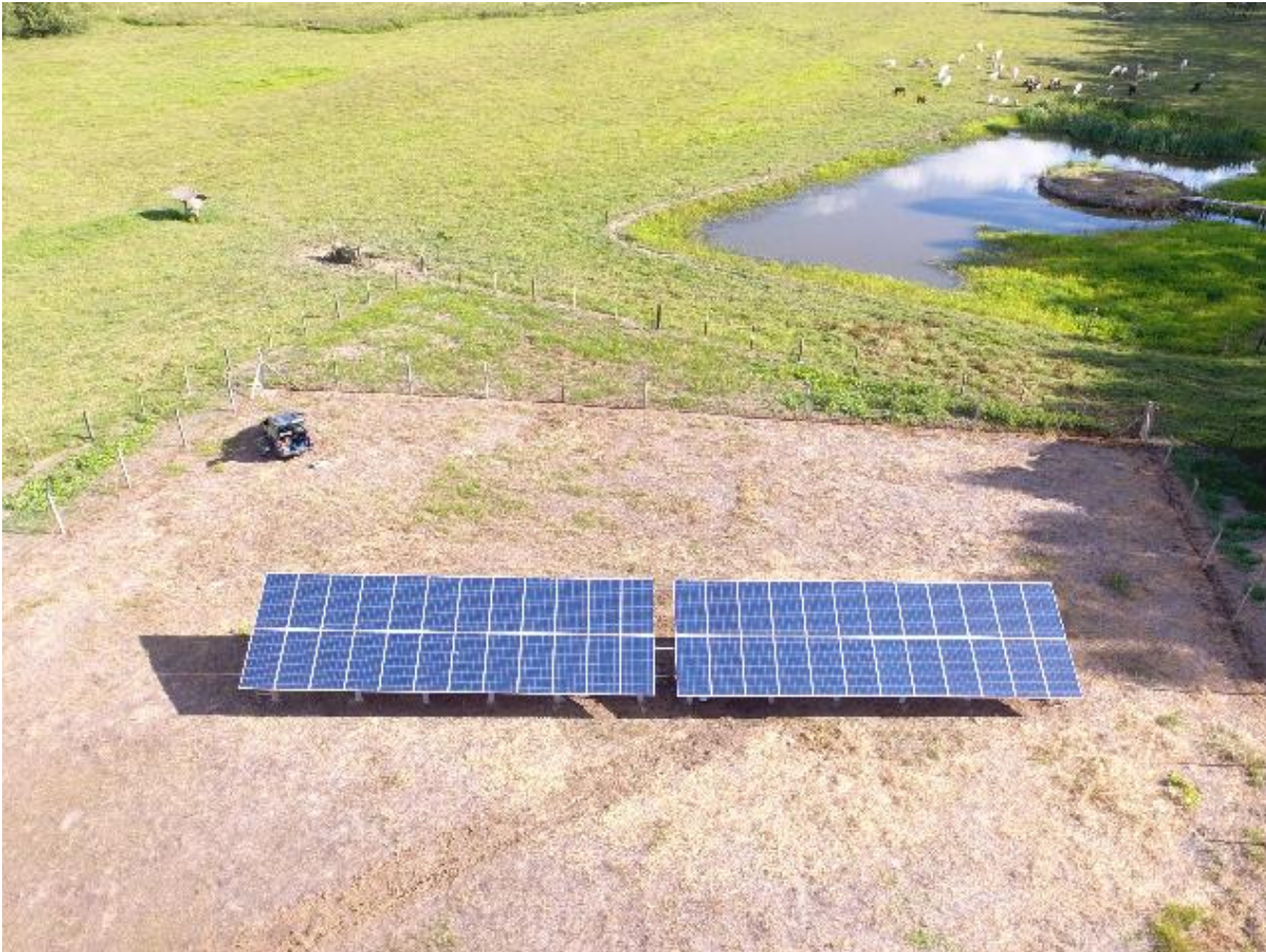
Figura 2.4: Geração Compartilhada - Cooperativa Energia Enercred – Pedralva – MG. Fonte: Enercred (2017).
