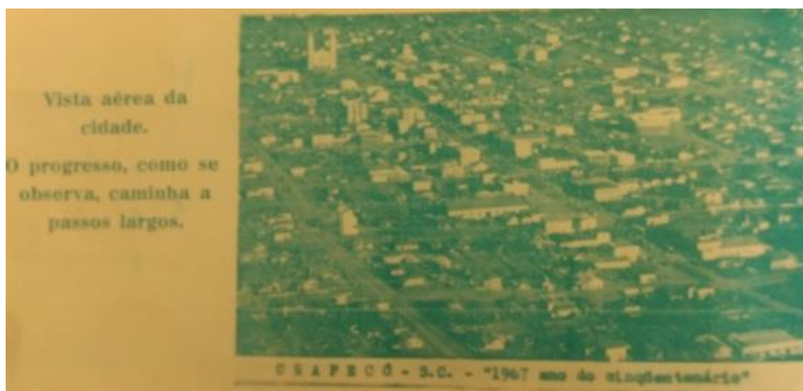
Imagem 2: “O progresso, como se observa, caminha a passos largos”.
