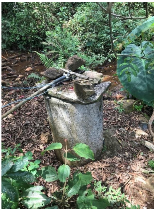
Figura 24: Foto da proteção da nascente após seis anos de projeto.
