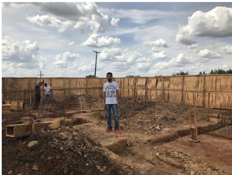
Figura 26: Barracão da agroindústria da COOPAFI em fase de construção
