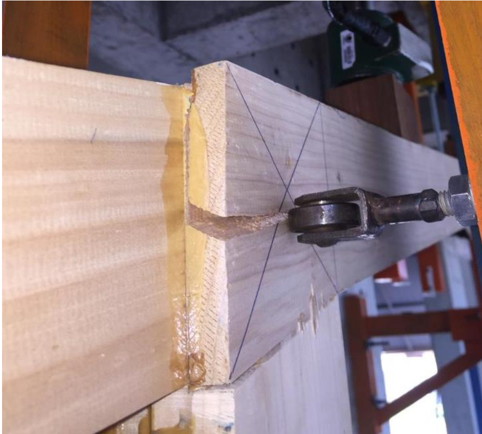
Figura 23 - Detalhe de Ruptura no nó C na estrutura do ensaio 05, pórtico 05
