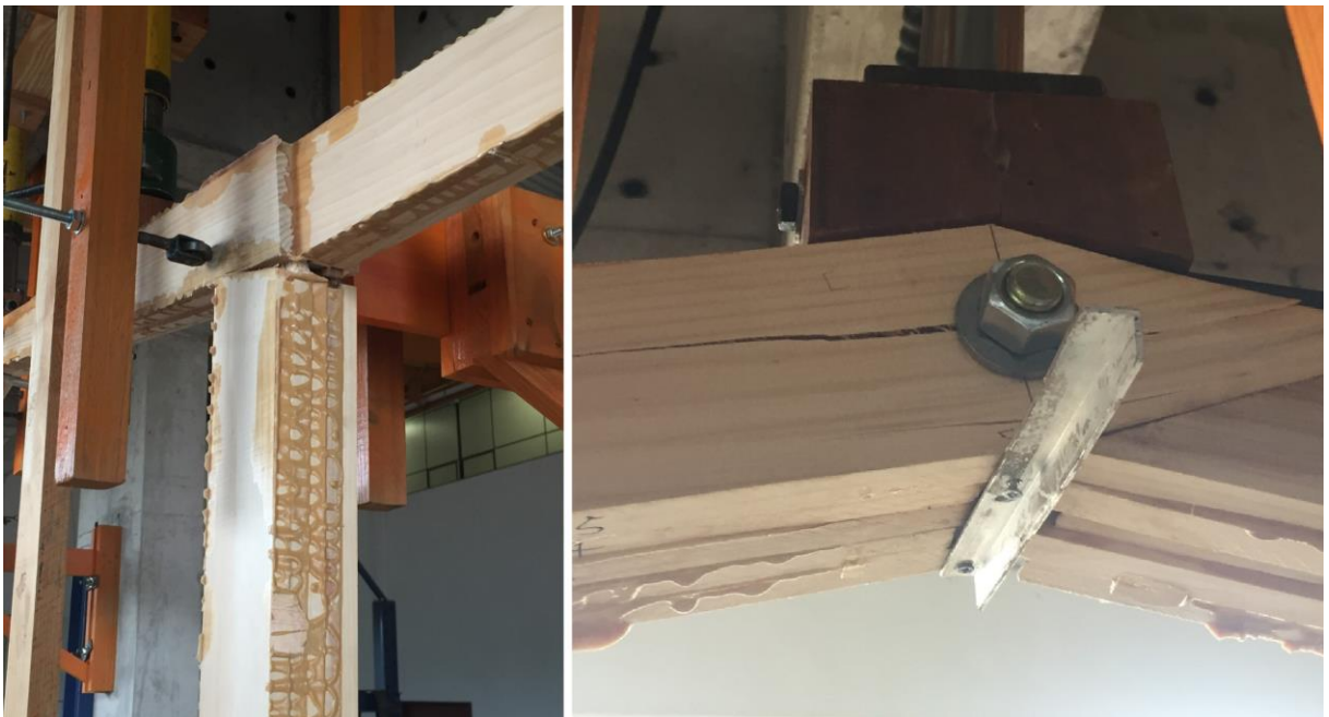
Figura 20 - Detalhe de Ruptura nos nós C e E na estrutura do ensaio 02, pórtico 02
