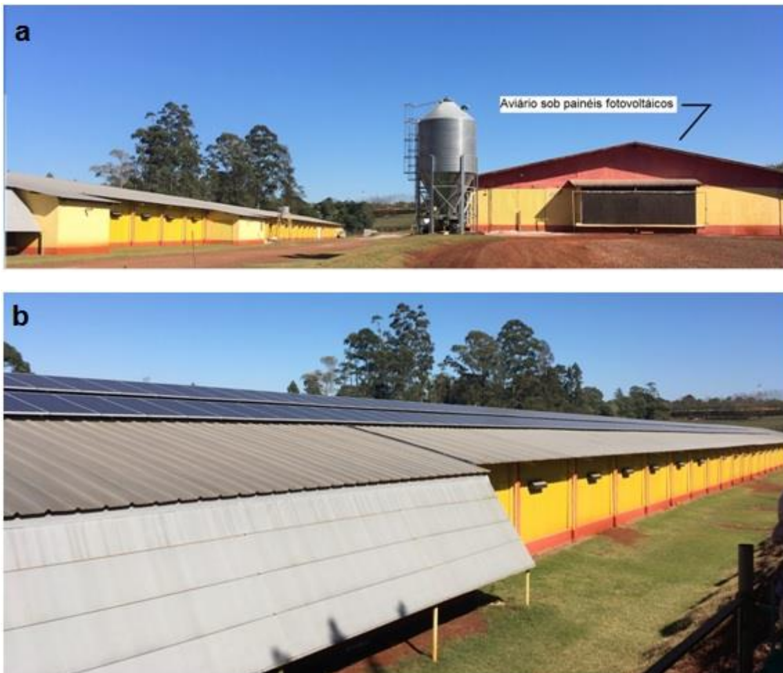
Figura 07– Aviários analisados em estudo (a) e painéis fotovoltaicos (b) (Fonte: AUTOR, 2018).
