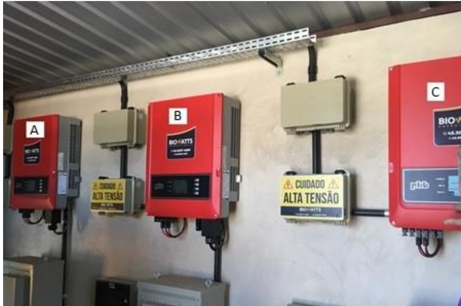
Figura 10 – Inversores modelo PHB25K-DT da marca PHB e suas nomenclaturas (Fonte: AUTOR, 2018)
