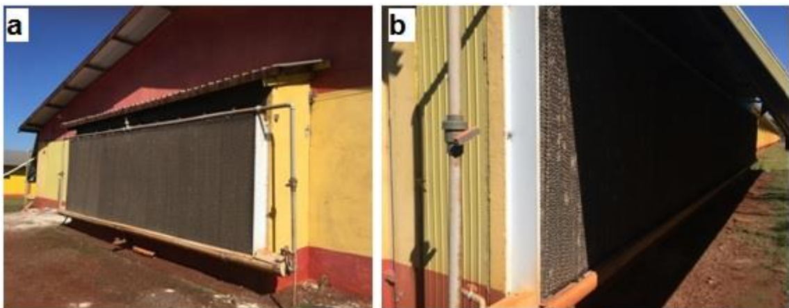
Figura 14: Padcooling frontal (a) e lateral (b). (Fonte: AUTOR, 2018)
