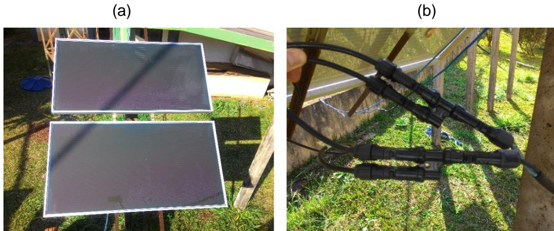
Figura 19. Painel Fotovoltaico amorfo instalado (a); conector tipo Y, ligado em paralelo (b).
