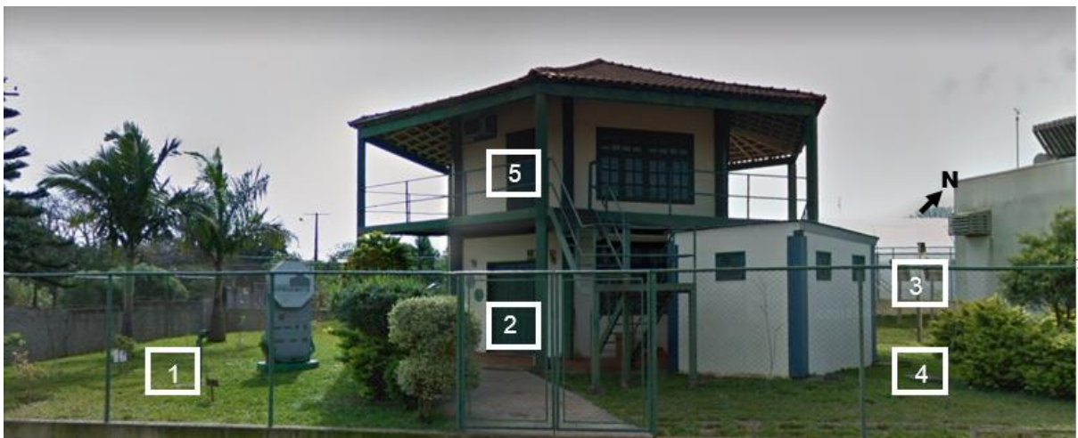
Figura 21: Vista Panorâmica do Centro de Análise de Sistemas Alternativos e da implantação dos experimentos. 1-Sistema de irrigação outdoor; 2- Sistema de irrigação indoor; 3- Painel fotovoltaico do sistema; 4- Reservatório de água com sistema motobomba; 5- Localização do datalogger; N- Norte geográfico do local.
