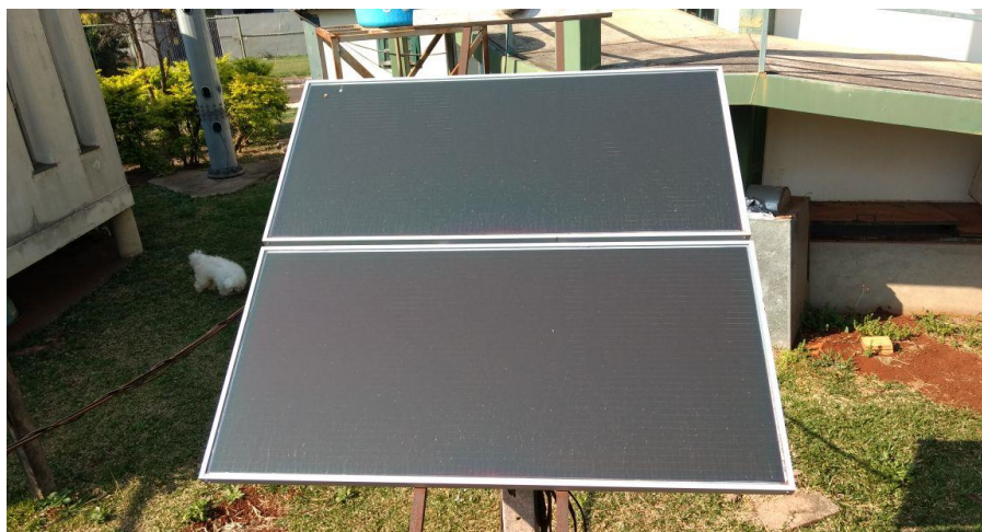
Figura 23. Painel fotovoltaico de silício amorfo instalado para o experimento na inclinação 35 graus e voltado para o norte geográfico.
