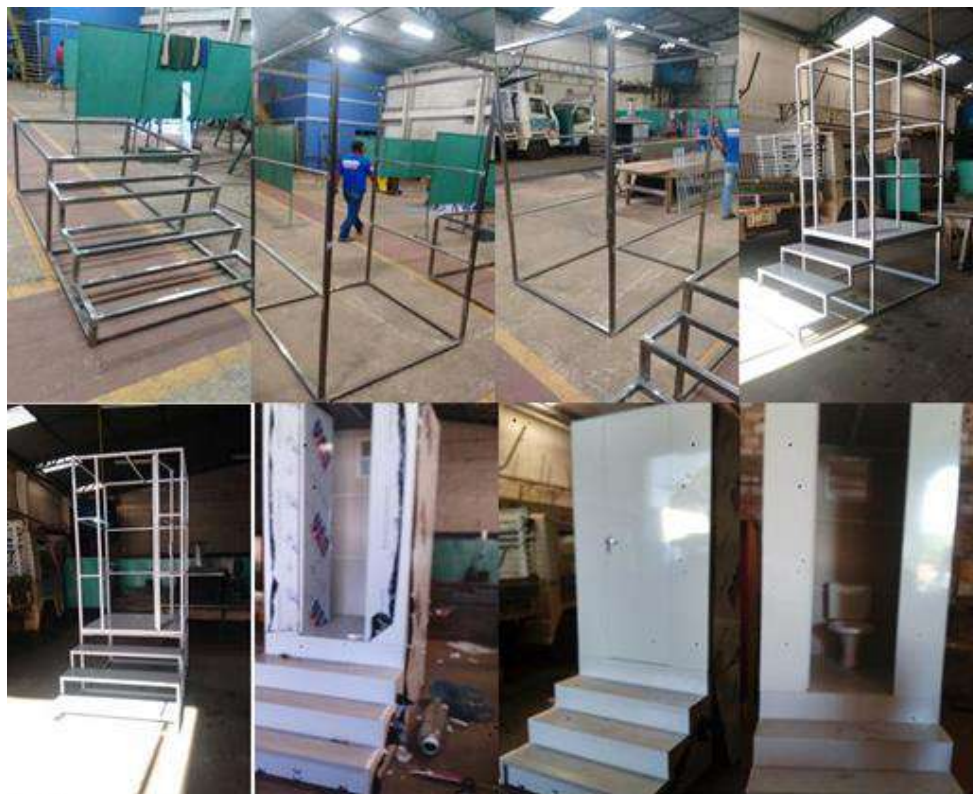
Figura 56: Aspectos Construtivos do Banheiro Móvel.
