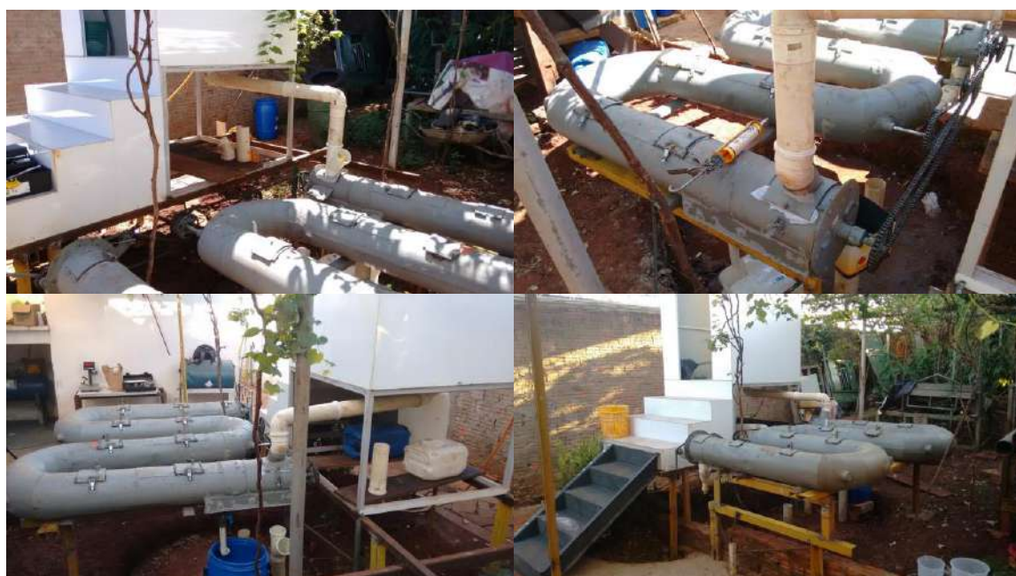
Figura 70: Detalhes Construtivos e Instalação do Protótipo do BAH – Versão 2.0.
