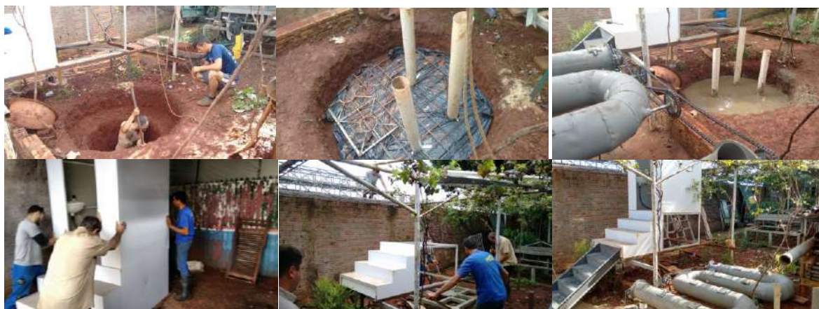
Figura 73: Instalação do Sistema de Tratamento de Águas Negras.
