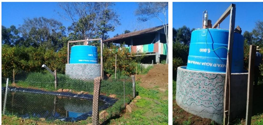
**Figura 18.** Propriedade 5 – Biodigestor familiar alimentado com dejetos de ovelha.
