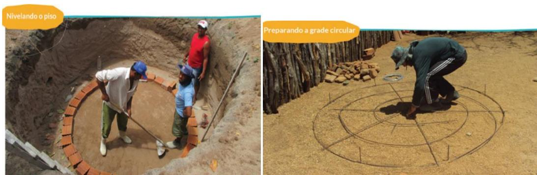
**Figura 7.** Preparação do tanque de fermentação do biodigestor
