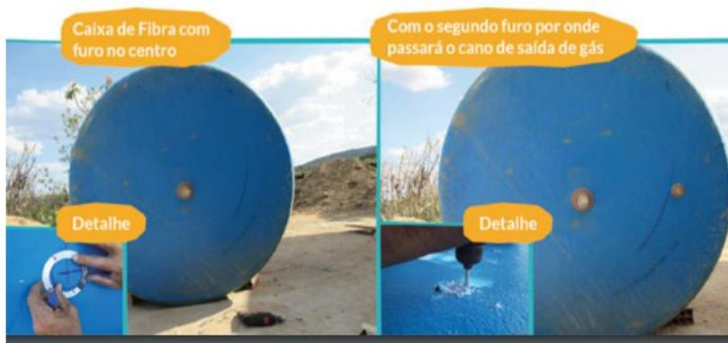
**Figura 10.** Câmara de armazenamento do biogás.
