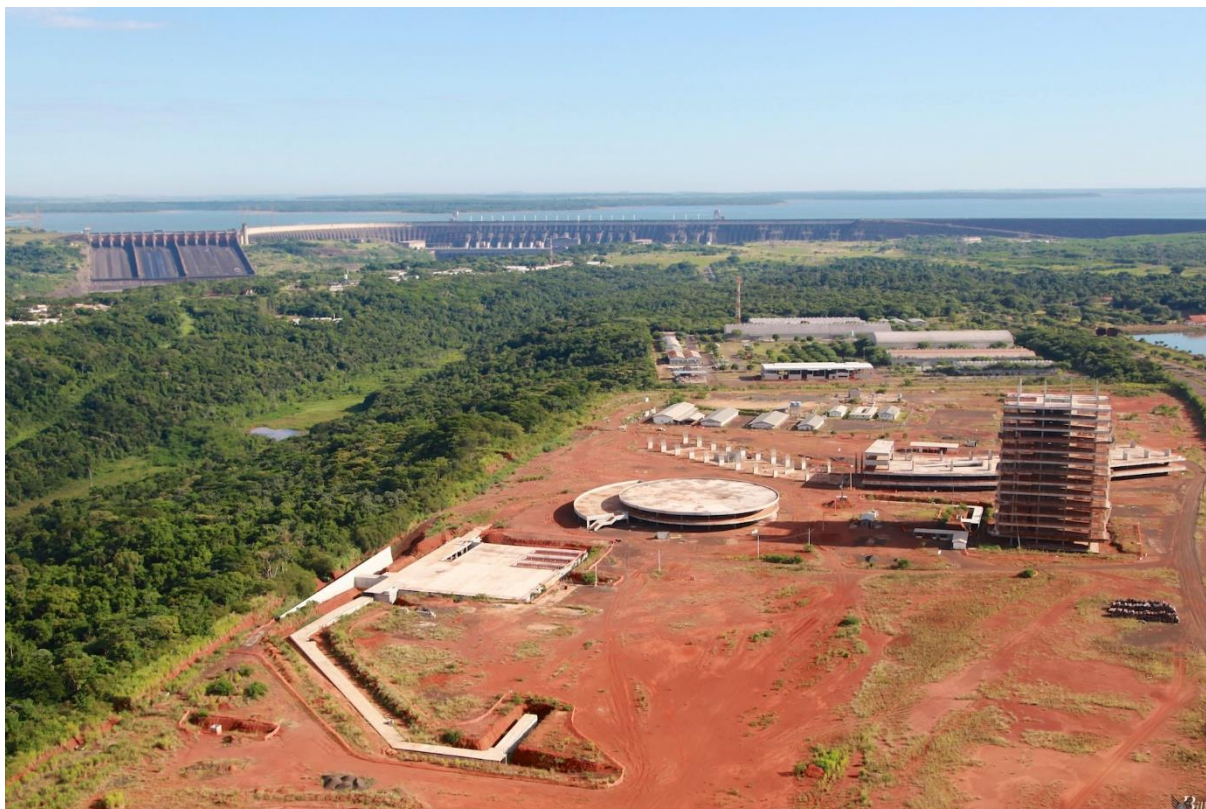
Figura 03. 6: Imagem aérea do canteiro de obra do Campus da UNILA. Fonte: Arquivos SECIC, UNILA (2018).
