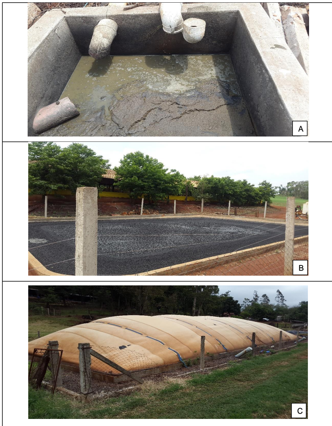
Figura 8 – Estruturas de alguns sistemas de tratamento de empreendimentos suinícolas estudados - caixa de passagem de dejetos (A); lagoa de estabilização (B) e biodigestor (C).
