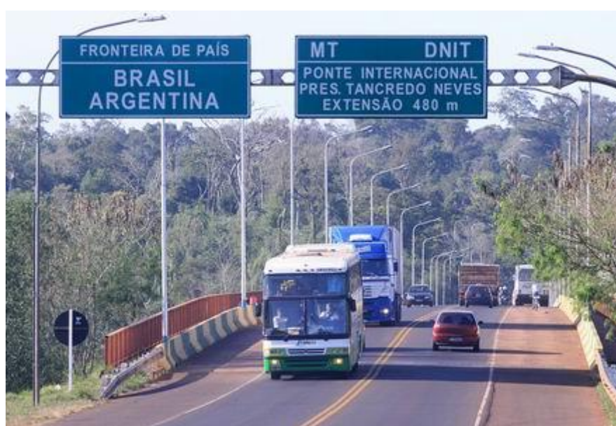
Figura 23 - Ponte Internacional da Fraternidade Fonte: Clickfoz (2017)
