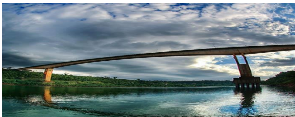
Figura 4 - Ponte Tancredo Neves – Ponte Internacional da Fraternidade Fonte: Tribuna Foz 2016
