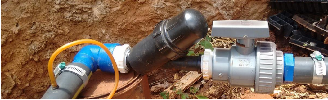
Figura 4 Cabeçal de controle (Registro de esfera e Filtro de discos). Fonte: Elaborado pelo autor.
