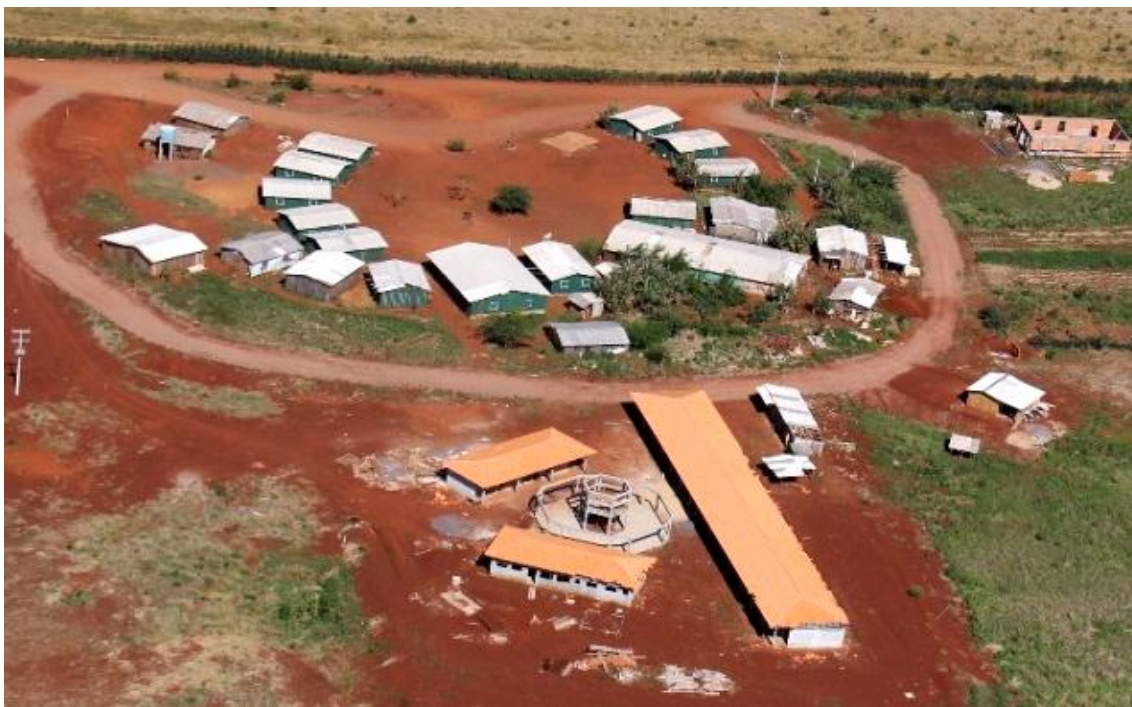
FIGURA 18 – Vista aérea (1) da Escola construída pelas famílias assentadas e a obra da nova estrutura sendo construída com recursos do governo Federal/MEC.
