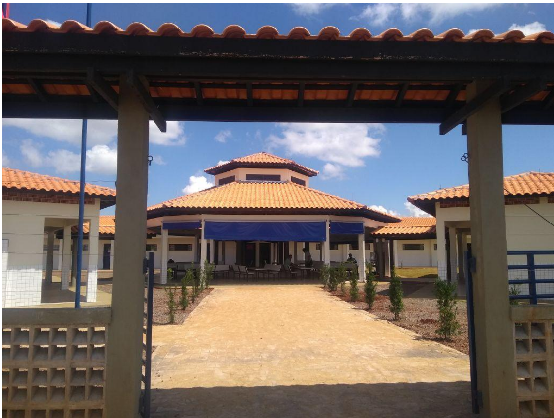
FIGURA 21 – Entrada da nova estrutura da Escola Municipal do campo Zumbi dos Palmares.
