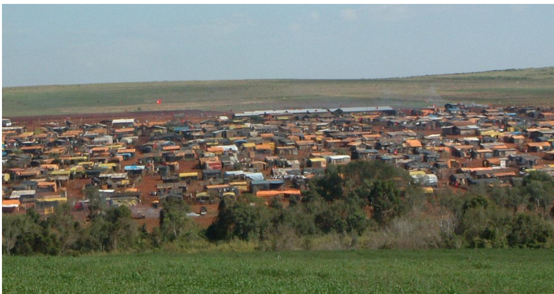
FIGURA 10 – Visão parcial do Acampamento Primeiro de Agosto (2005).
