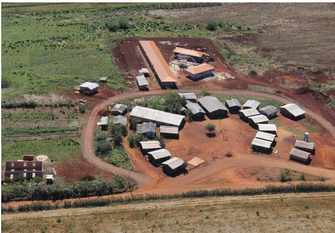
FIGURA 19 – Vista aérea (2) da Escola construída pelas famílias assentadas e a obra da nova estrutura sendo construída com recursos do governo Federal/MEC.
