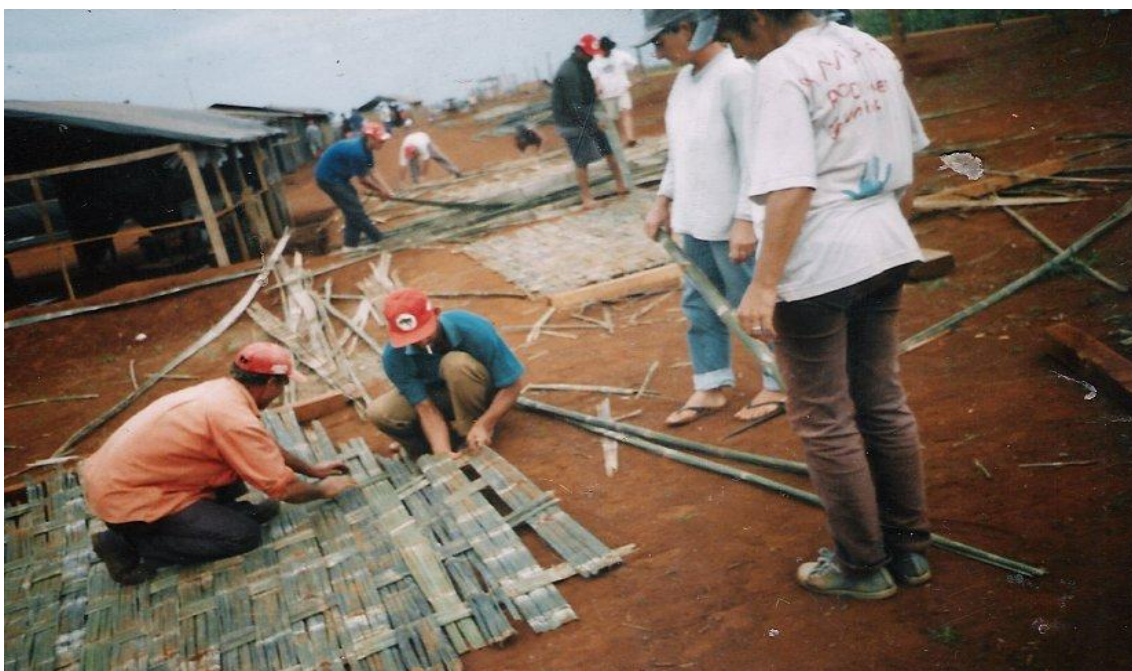
FIGURA 11 – Comunidade contruindo as salas de aula do Acampamento 1º de Agosto.
