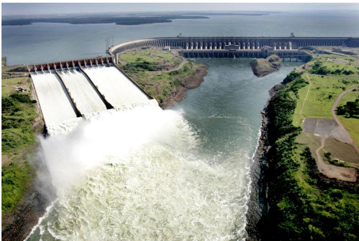
Figura 4. Visão panorâmica da barragem da Usina Hidrelétrica de Itaipu.
