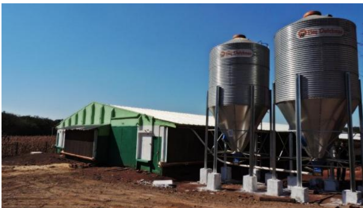
Figura 40: Sistema de nutrição – Silos Big Dutchman – Capacidade 16 toneladas.
