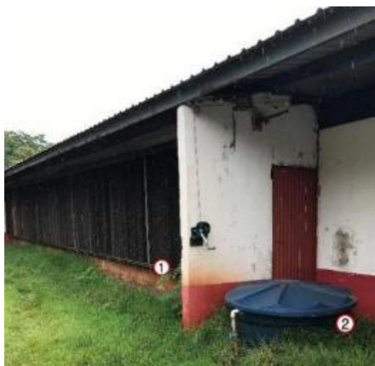
Figura 59: Sistema de abastecimento de água. (1) Sistema pad cooling . (2) Reservatório 500 litros – pad cooling .
