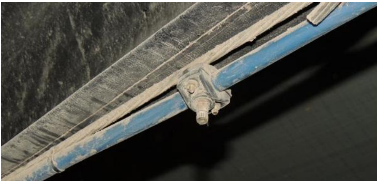
Figura 26: Sistema de resfriamento – Nebulizador. Detalhe da biqueira.
