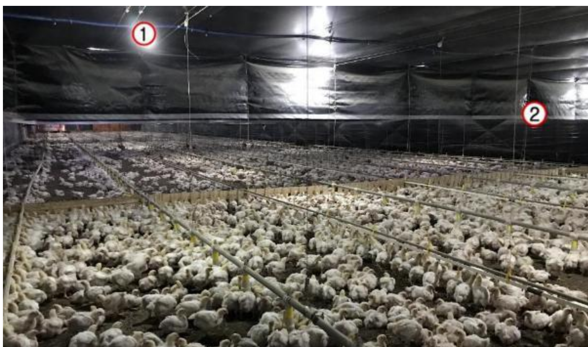
Figura 21: Sistema de cobertura do aviário A2 - telha aluzinco com forração de lona. (1) Forro em lona preta (2) Refletor de ar em formato retangular em lona preta.
