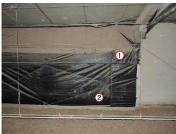
Figura 17: Vedação lateral do aviário A1. Detalhe do fechamento lateral. (1) Bandô tipo Y na cor preta (2) Cortina preta – prata (face interna – face externa).
