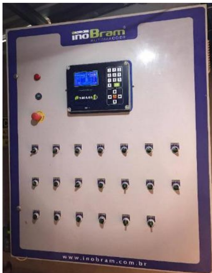
Figura 45: Sistema de controle do aviário A2 – Inobram SMAAI 4.
