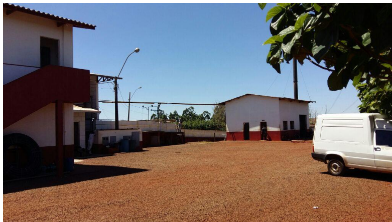
Figura 19 - Abatedouro de Suínos e Bovinos em Santa Terezinha de Itaipu, PR
