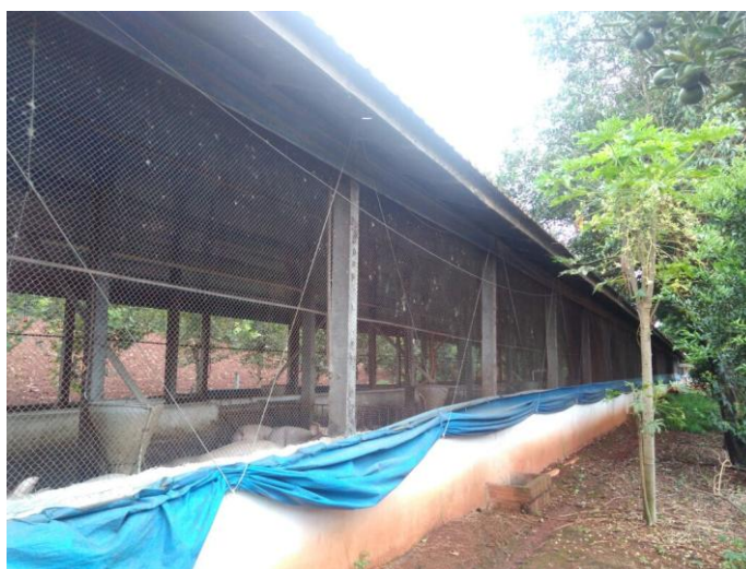
Figura 12 - Fechamento lateral em pocilga convencional de criação de suínos no Distrito de Toledo – Propriedade 02
