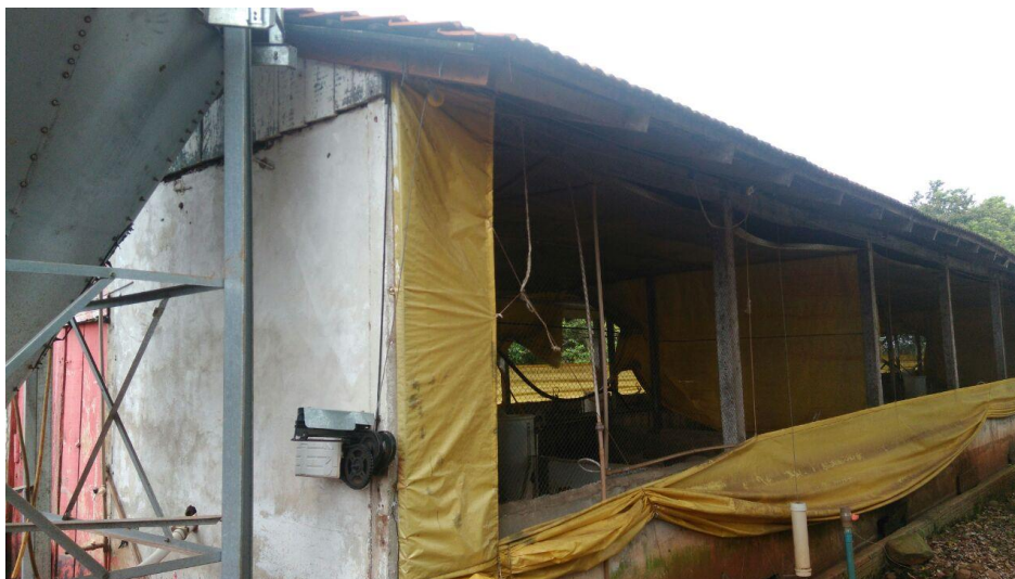
Figura 9 - Fechamento lateral em pocilga convencional de criação de suínos no Distrito de Toledo - Propriedade 01
