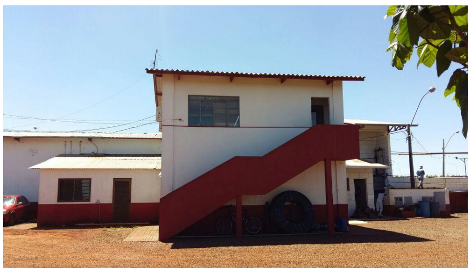
Figura 18 - Abatedouro de Suínos e Bovinos em Santa Terezinha de Itaipu, PR
