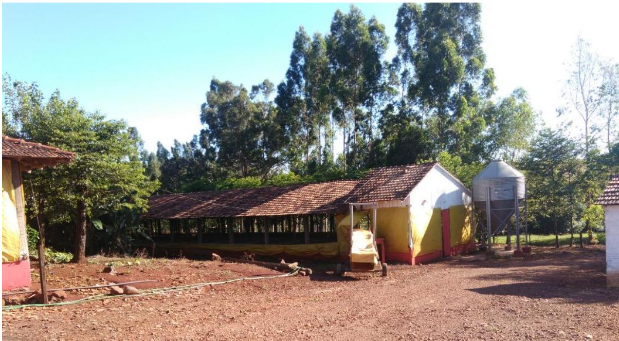
Figura 15 - Fechamento lateral em pocilga convencional de criação de suínos no Distrito de Toledo – Propriedade 03
