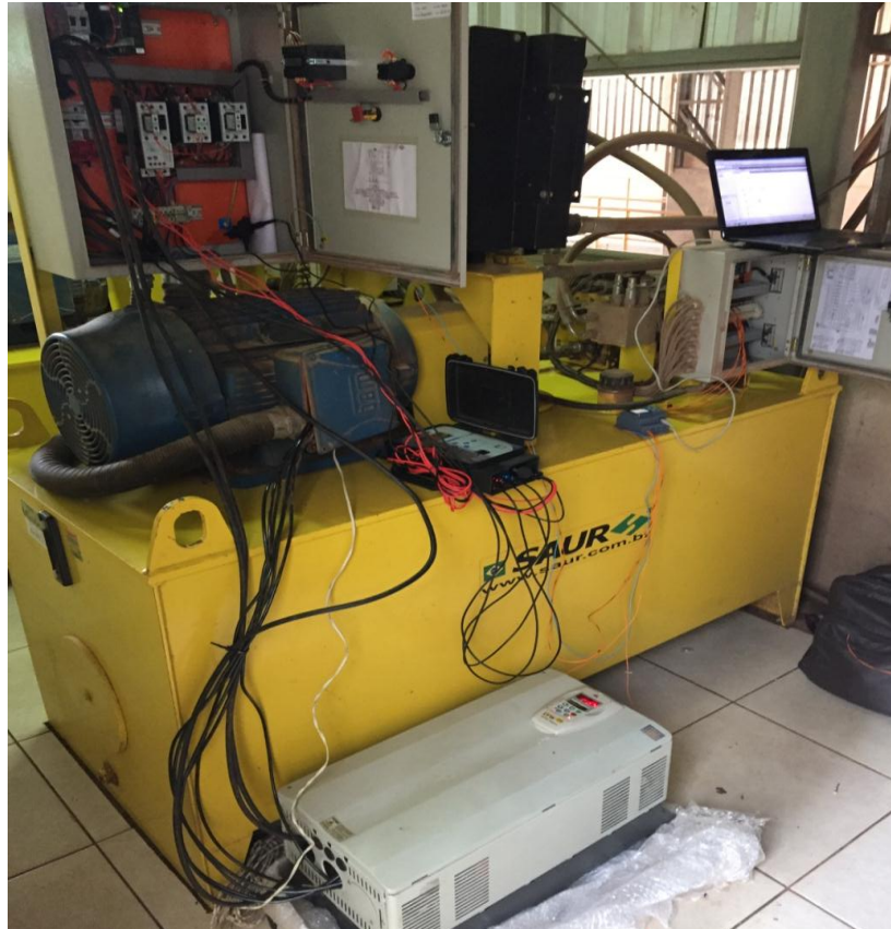
Figura 23. Painel de comando elétrico da unidade hidráulica com analisador de energia, instalado com o inversor de frequência.
