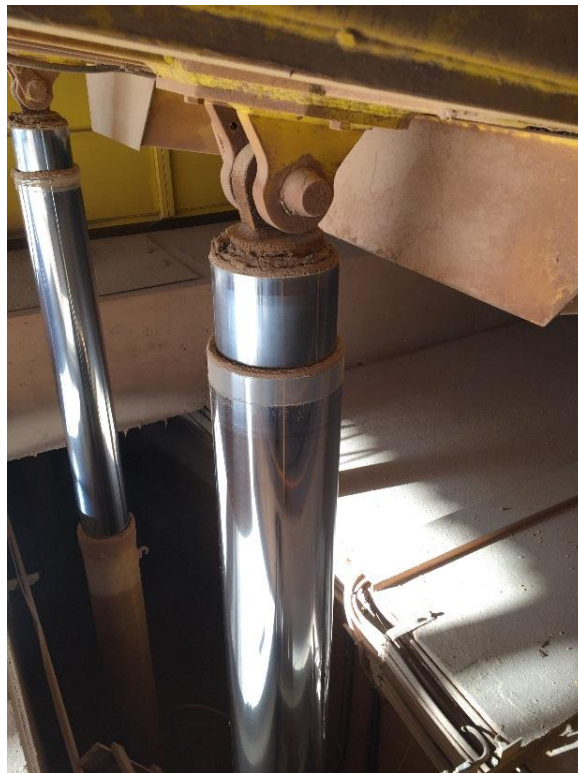
Figura 17. Cilindro hidráulico – plataforma de descarga 21 metros.
