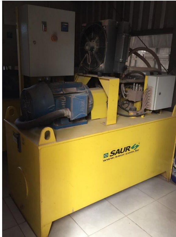
Figura 16. Unidade Hidráulica – plataforma de descarga 21 metros.
