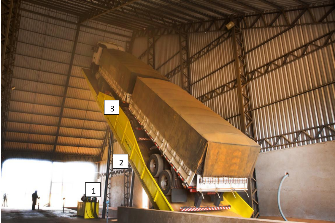
Figura 4. Plataforma de descarga. Fonte: Saur. 2017.
