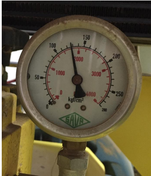
Figura 18. Manômetro da unidade hidráulica – plataforma de descarga 21 metros.
