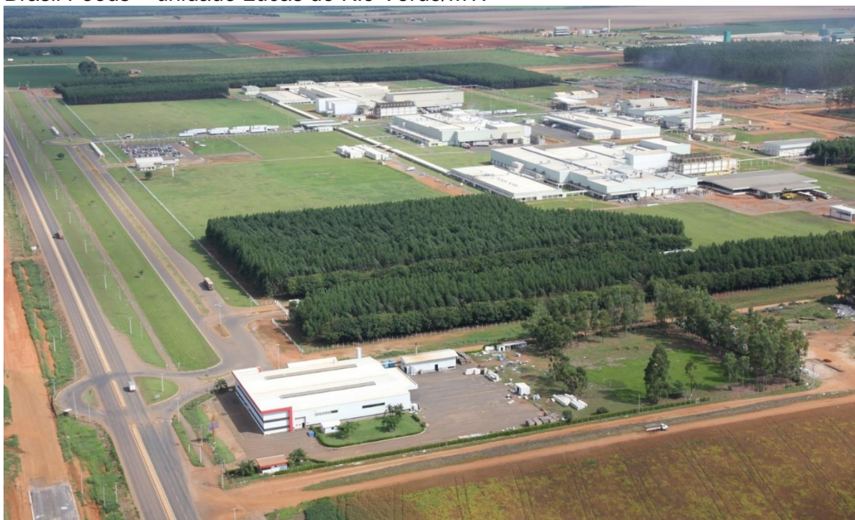
Figura 9: Vista aérea da área que compreende o complexo agroindustrial da BRF Brasil Foods – unidade Lucas do Rio Verde/MT.
