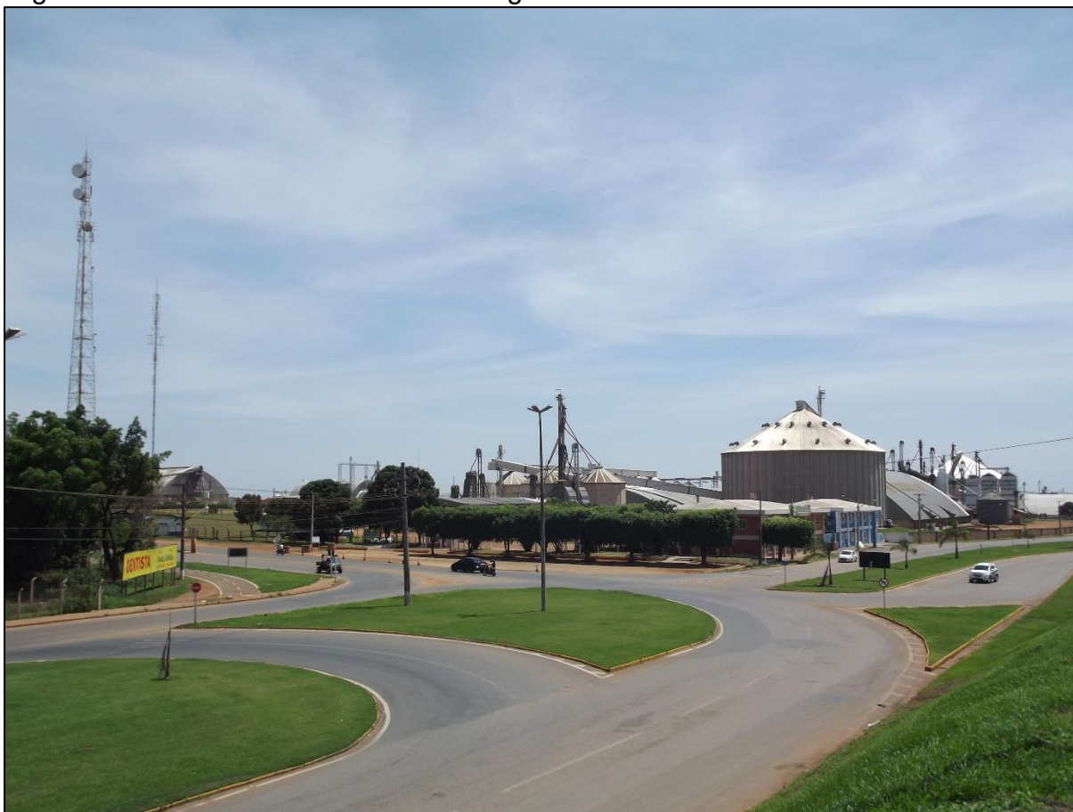
Figura 11: Silos de armazenamento de grãos na cidade de Lucas do Rio Verde/MT.
