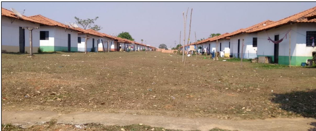
Figura 10: Conjunto habitacional que abriga os trabalhadores da BRF Brasil Foods – Unidade Lucas do Rio Verde/MT.
