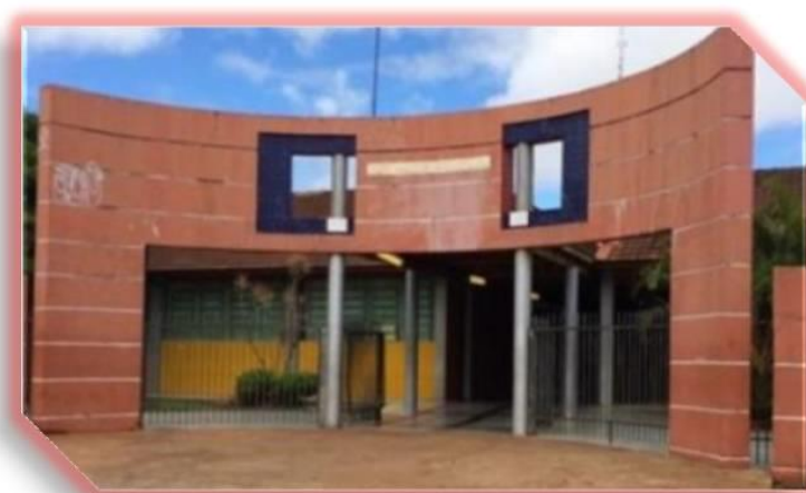
Figura 54 – Fachada do Colégio Mario Quintana
