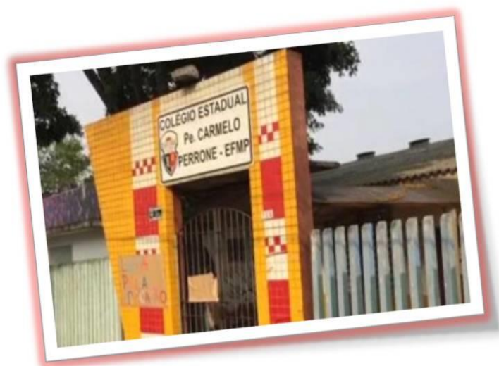
Figura 52 – Fachada do Colégio Padre Carmelo Perrone
