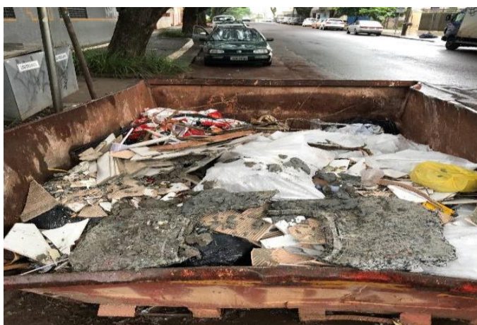
Figura 7 - Caçamba Estacionária com RCC Classes A e B (Bairro Centro). Fonte: Autor (2017).
