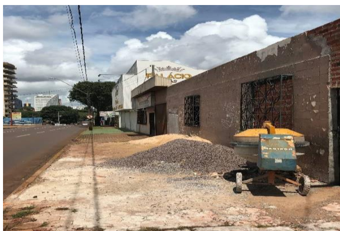
Figura 4 - Obstrução do Passeio Público (Bairro Centro). Fonte: Autor (2017).
