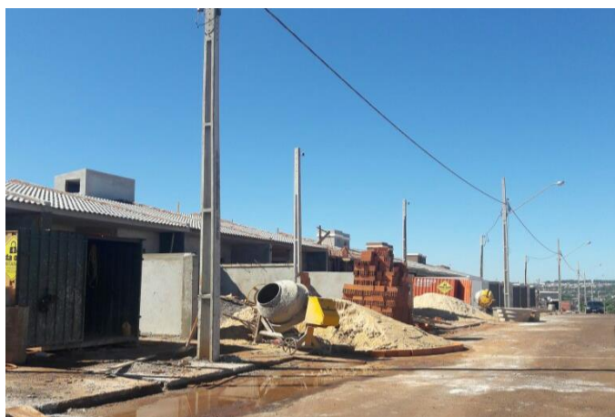
Figura 3 - Obstrução do Passeio Público (Bairro Morumbi). Fonte: Autor (2017).
