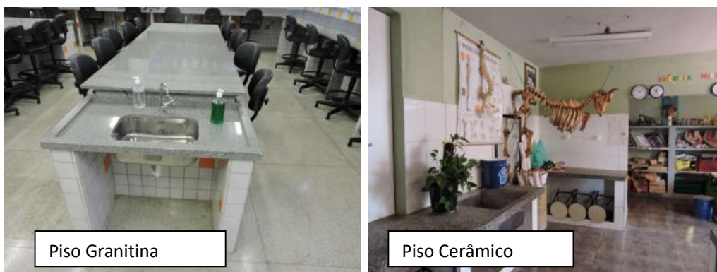
Imagem 21: Pisos adequados ao uso do laboratório de ciências
