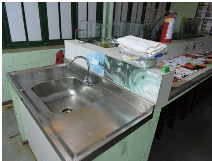
Imagem 23: Instalação de gás
