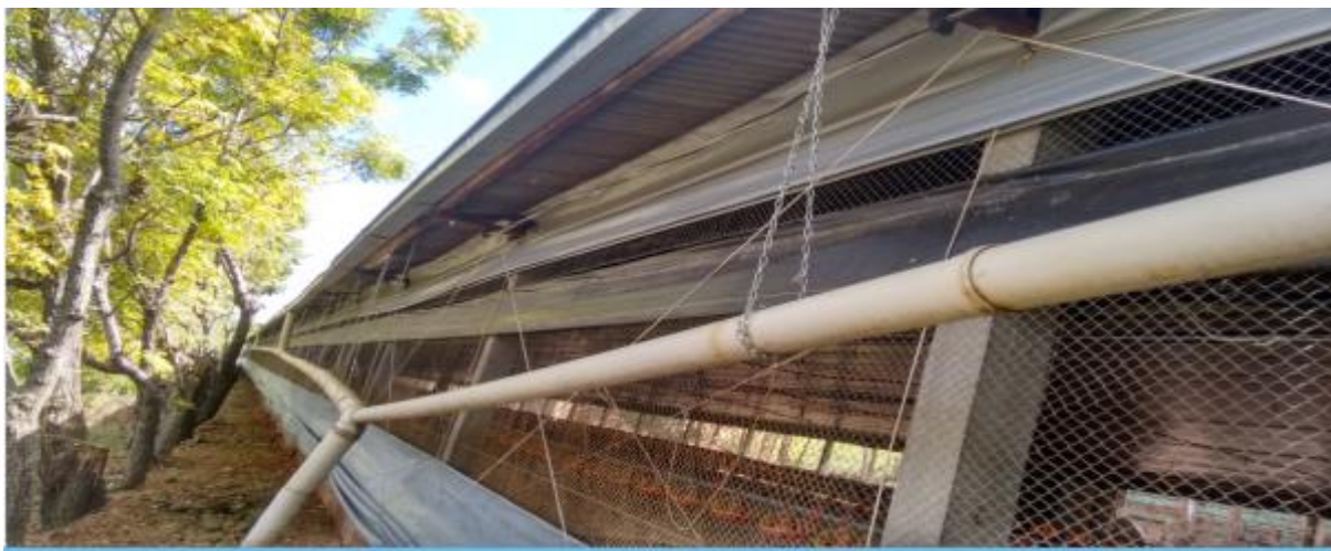
Figura 17: Sistema de captação de água de chuva do telhado do aviário
