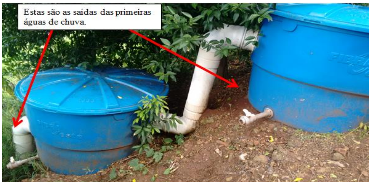
Figura 19: Sistema de filtragem da água de chuva
