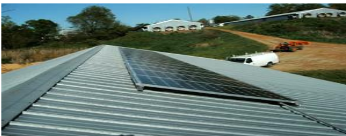
Figura 9: Aviário com módulos fotovoltaicos
