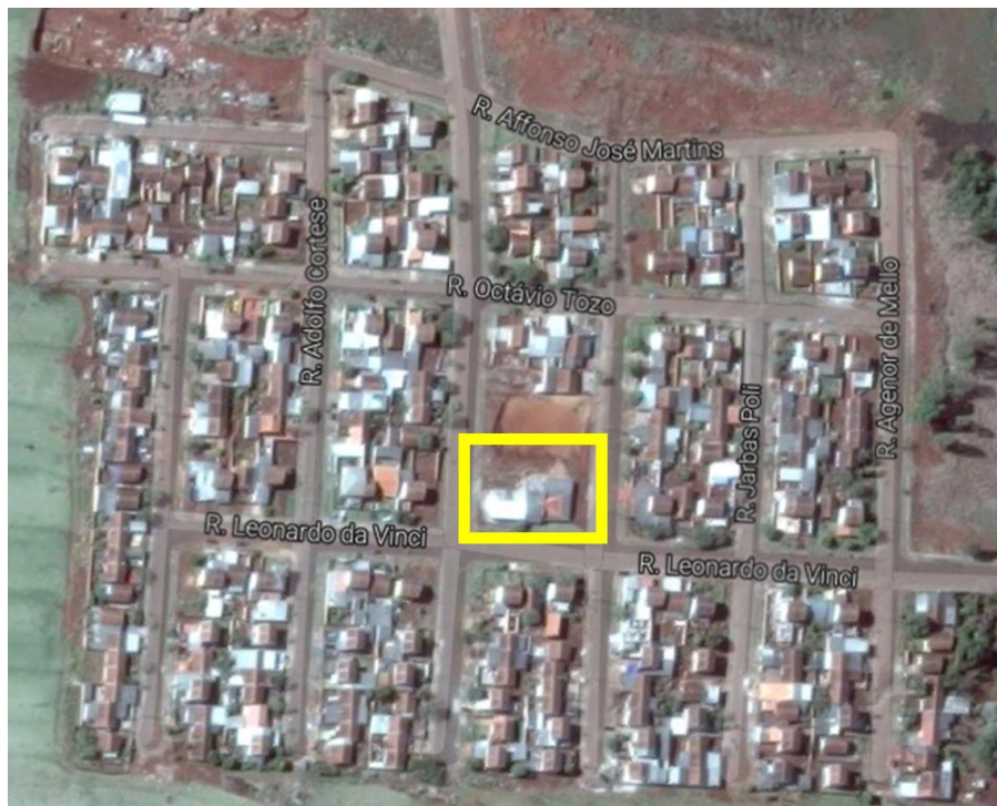
Figura 10. Lotes que formam o Conjunto Habitacional Sanga Funda
