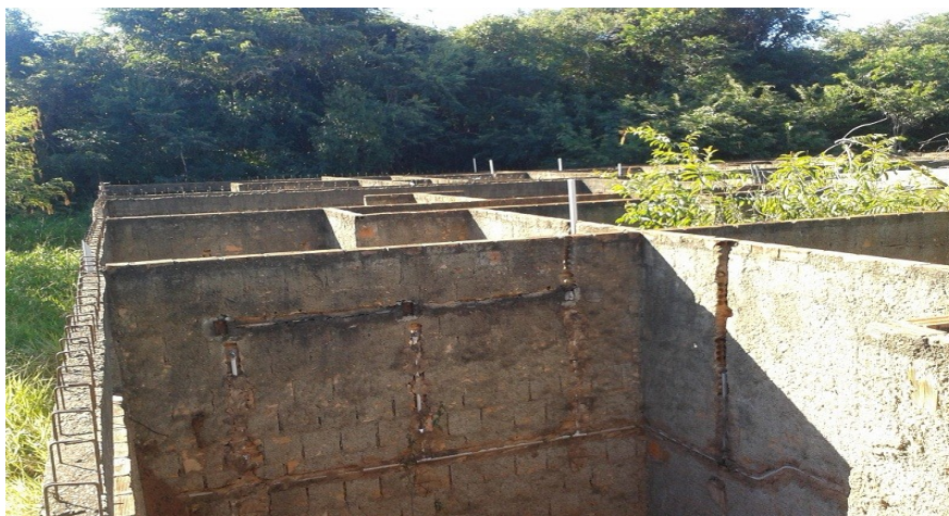
Figura 5 – Ruínas do prédio onde seriam instalados vestiários estudantis
