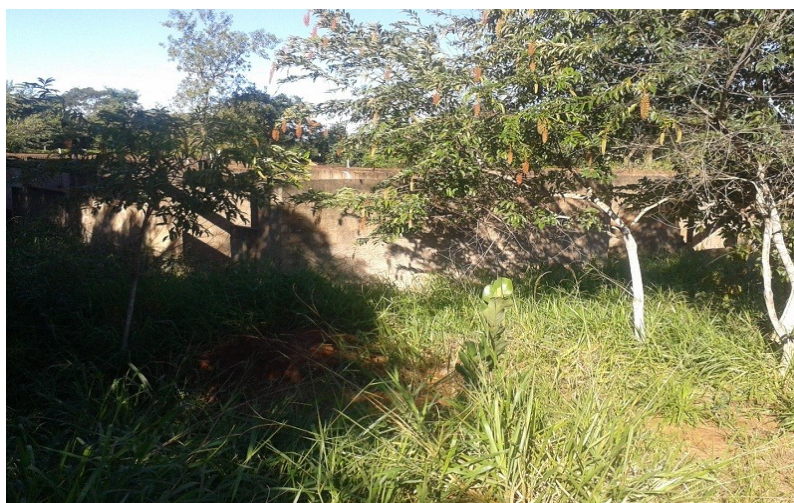
Figura 4 – Ruínas do prédio onde seriam instalados os alojamentos estudantis
