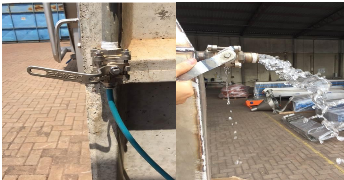
Figura 4.21 - Processo de abastecimento de água na caldeira. Fonte: Resultado da pesquisa.
