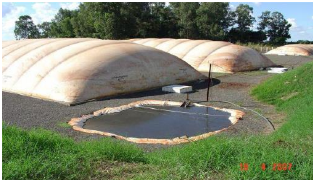
Figura 7: Biodigestor e tanque de coleta e armazenagem dos dejetos estabilizados.
