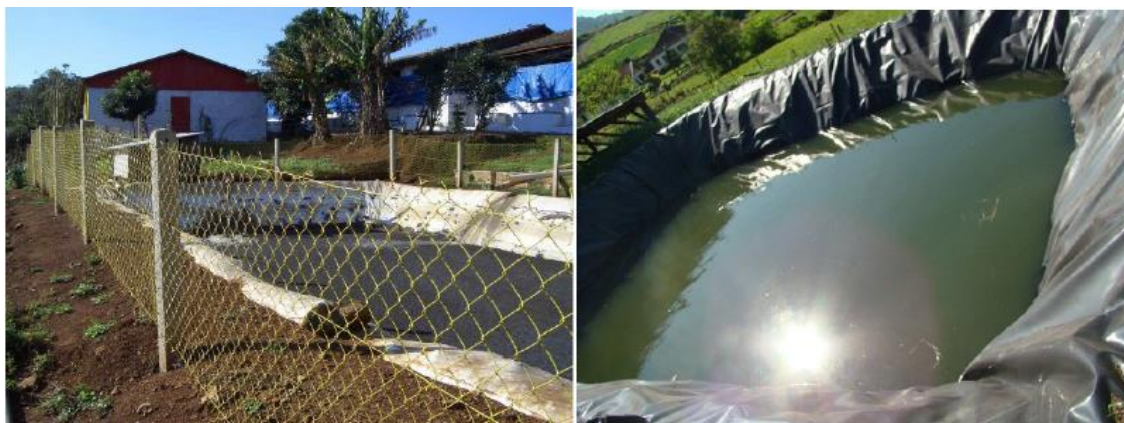
Figura 8: Esterqueiras construídas com lona de PVC ao lado de granja de suínos.
