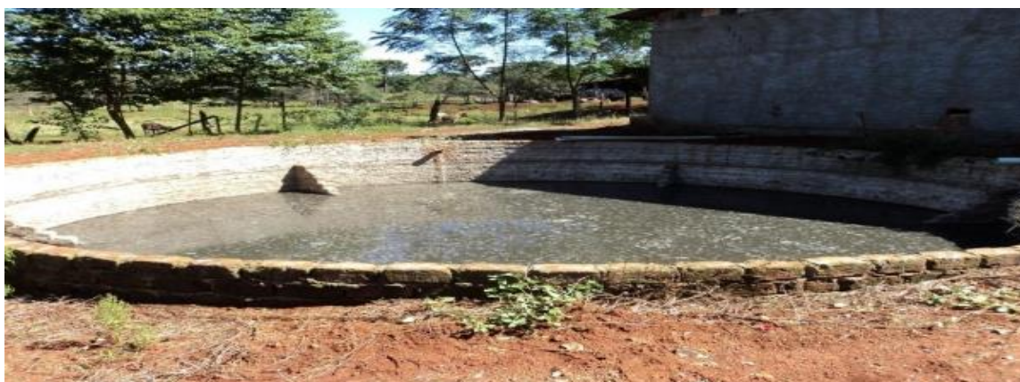
Figura 10: Esterqueira para armazenagem de dejetos líquidos de suinocultura.
