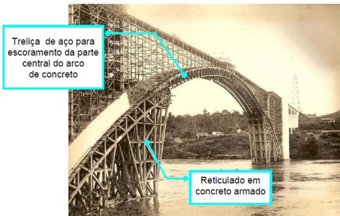
**Figura 6 e 6.1** - Detalhes da montagem da estrutura do arco da Ponte da Amizade para recebimento do concreto. Fonte: <http://aquarius.ime.eb.br/~webde2/prof/ethomaz/baumgart/baumgart01.pdf> - Acesso em: 23. Jun 2016.
