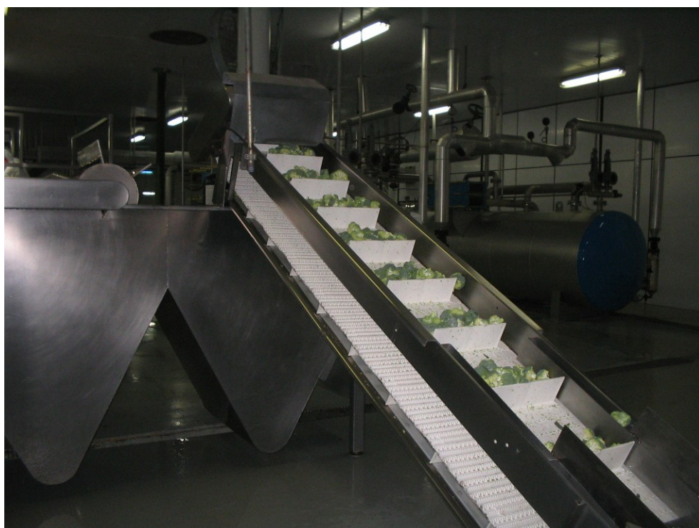
Figura 15 Vista da esteira que encaminha os floretes para o tanque de lavagem.
