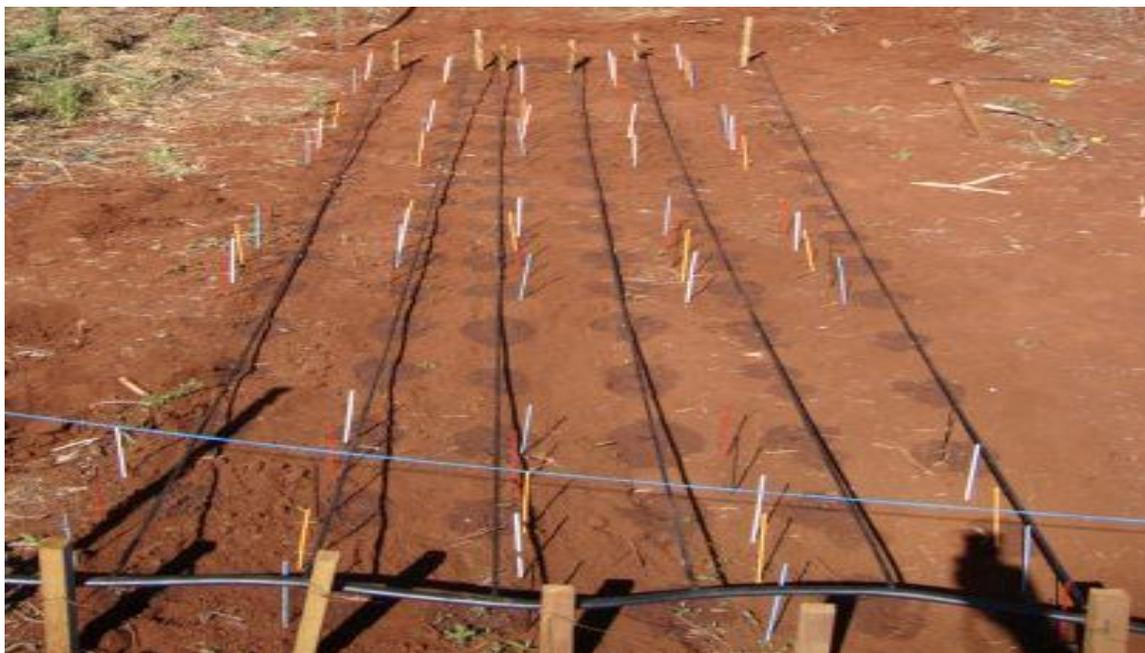
**Figura 8** Irrigação por gotejamento das cápsulas porosas, com uma linha principal e seis secundárias, NEEA, 2010.
