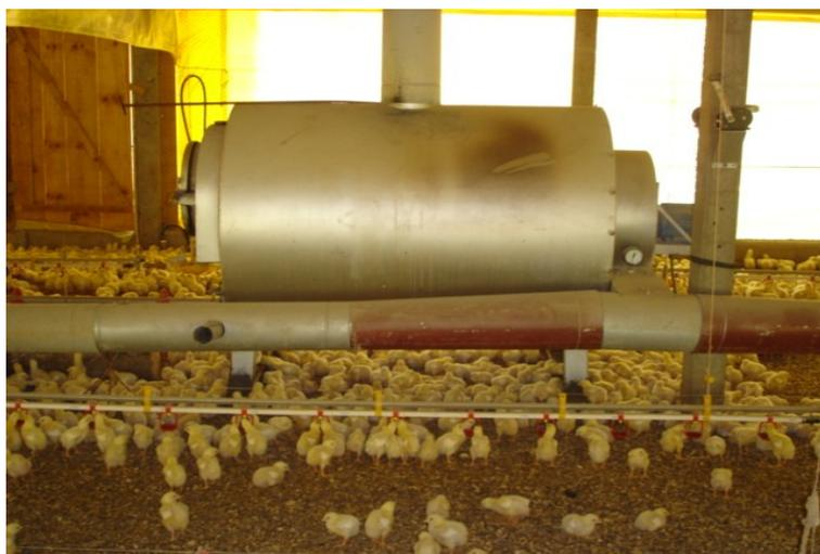
**Figura 5** - Aviário com sistema de aquecimento automático a lenha.
