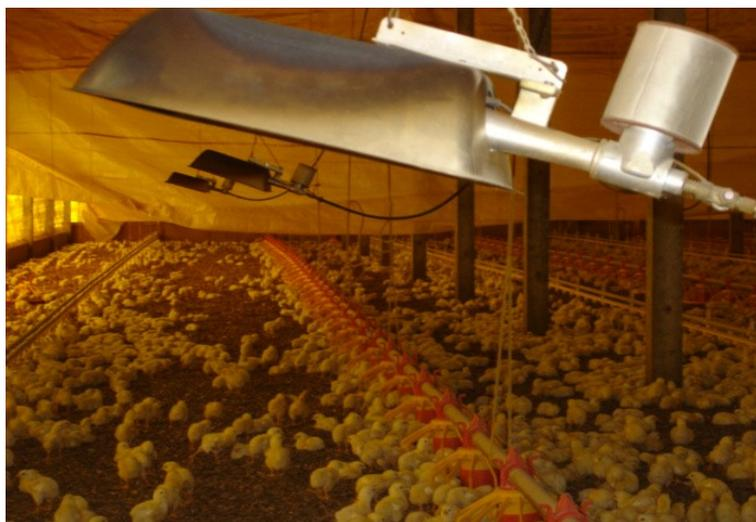
**Figura 8** - Aviário com sistema de aquecimento automático a gás.
