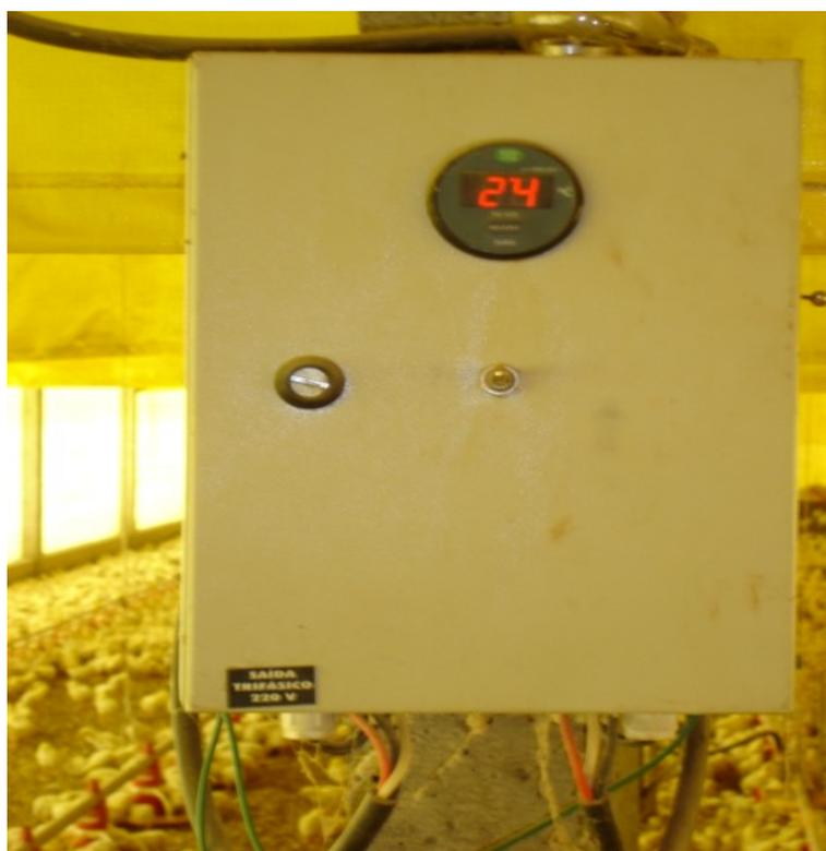
**Figura 6** - Painel de controle sistema aquecimento automático a lenha.
