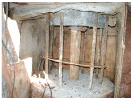
Figura 18 Nicho para posicionamento da célula de pressão.
