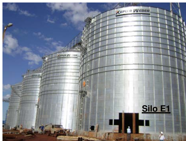
Figura 12 Vista geral da bateria E.
