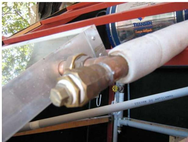
**Figura 13** - Isolamento térmico em polietileno expandido, recobrindo o tubo de cobre.
