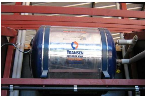
**Figura 10** - Reservatório térmico.
