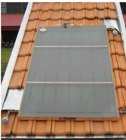
**Figura 8 -** Vista frontal do coletor – posição da fotografia: norte – sul. Lados esquerdo inferior e direito superior, os sensores de temperatura. Lado direito inferior, registro de manobra para drenagem do coletor.
