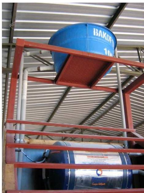
**Figura 12** - Reservatório de água fria na parte superior. Na parte inferior, vista de parte do reservatório térmico.
