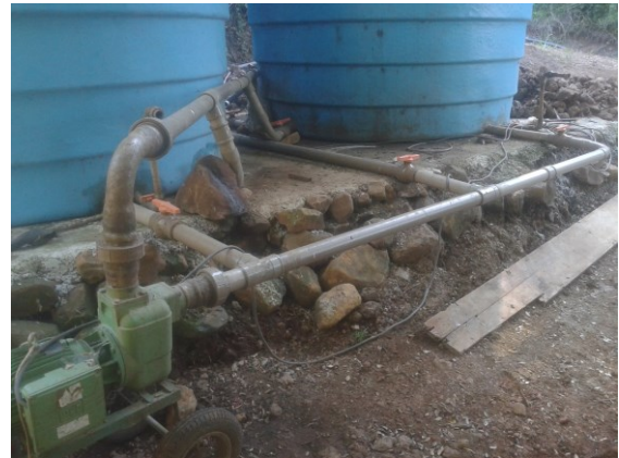
Figura 5 a) Reservatórios de digestato; b) Sistema de agitação do digestato armazenado.
