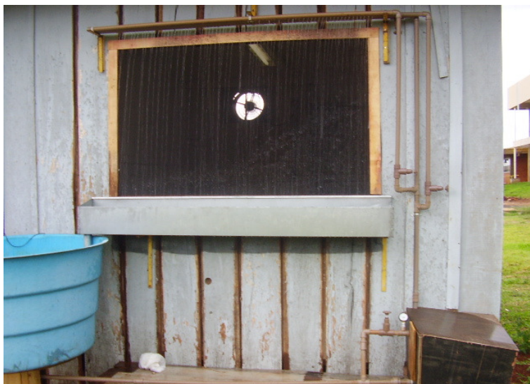
Figura 10 - Vista frontal da instalação do dispositivo.
