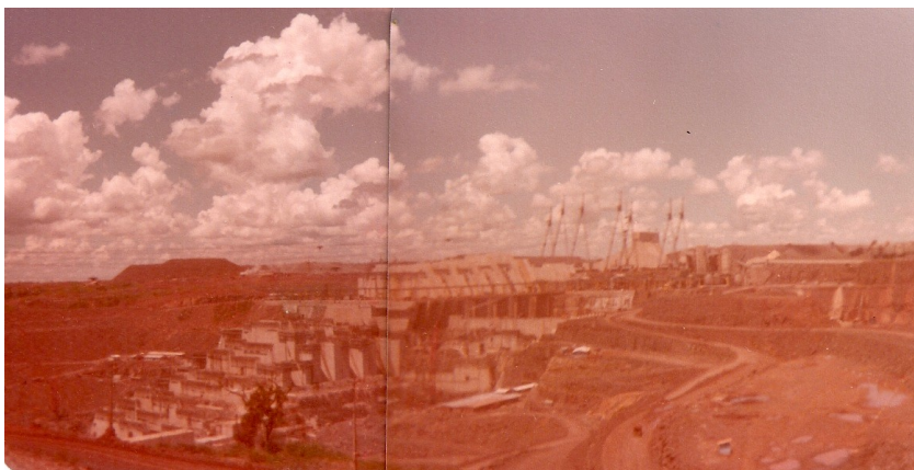
Foto 17 – Canteiro de obras da Hidrelétrica Binacional de Itaipu. 64
