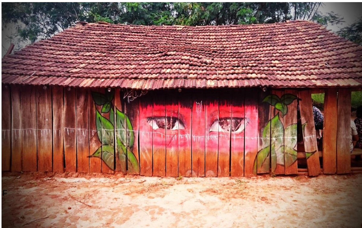
Figura 9 – Vista de Frente da Casa de Rezas
