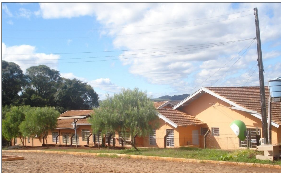
Foto 8 – Escola Municipal de Ensino Fundamental - Gilberto Tavares Fonte – Arquivo Pessoal.
