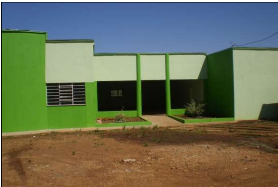
Foto 3: Centro de Eventos.
