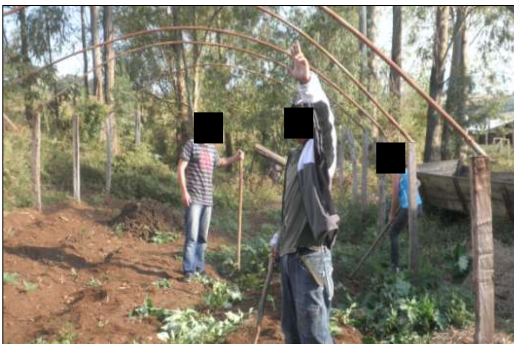
Foto 10: Olericultura – Construção da Estufa. Fonte: Arquivo Pessoal.
