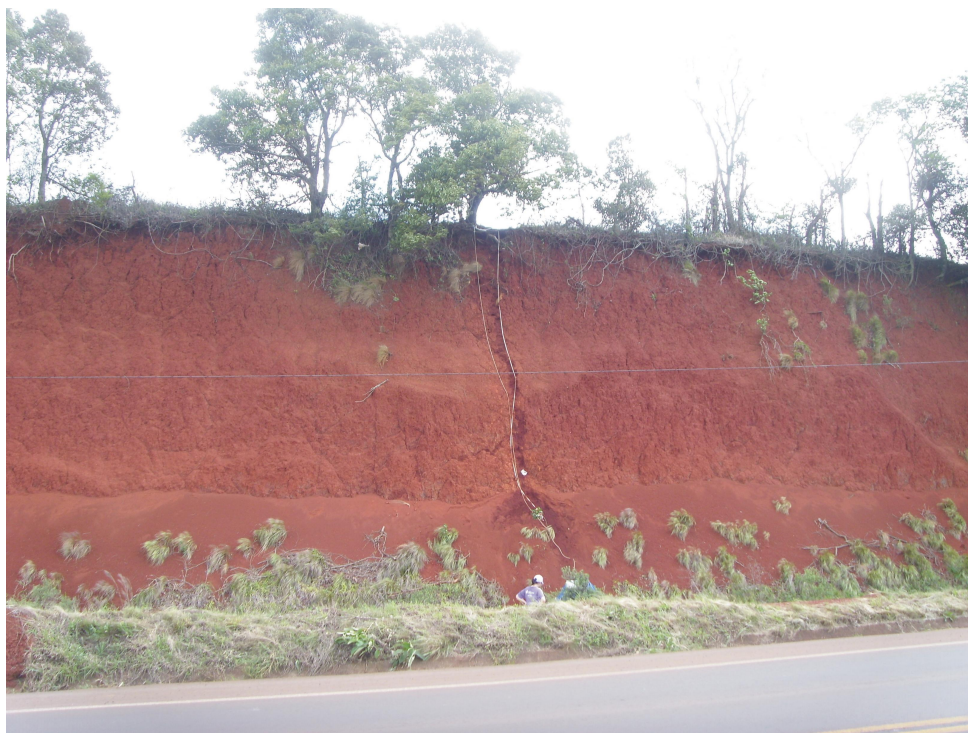
Figura 4 – Barranco exposto em corte da BR – 280, margem direita, sentido Francisco Beltrão/Clevelândia, demonstrando o perfil de alteração estudado.
