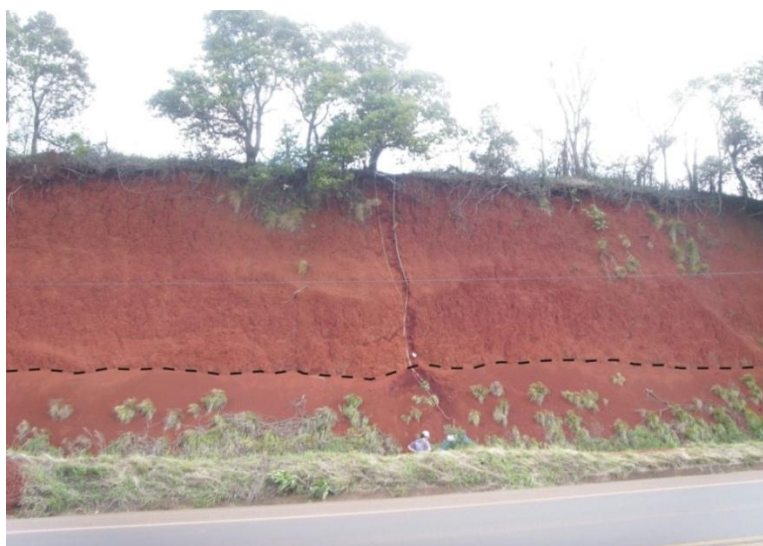
Figura 7 - Barranco exposto em corte da rodovia BR – 280, sentido Francisco Beltrão/ Clevelândia, demonstrando o perfil de alteração estudado. Nota-se o material desmoronado, soterrando a base do barranco a partir da linha pontilhada.
